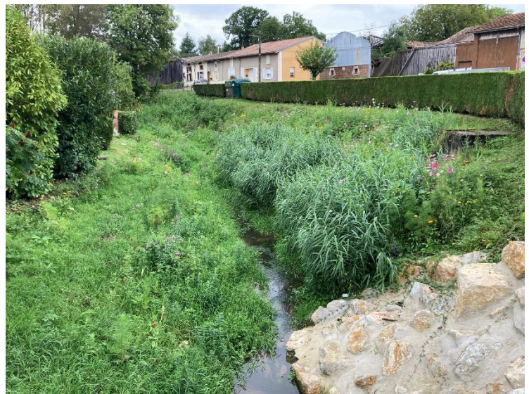
Vue sur le Gibermé depuis l'aval 3 mois après travaux.
