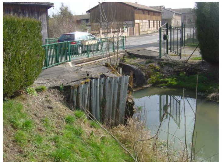
Vue sur le pont de la RD 63, le vannage et l'ancienne plateforme d'accès pompiers à la réserve incendie.
