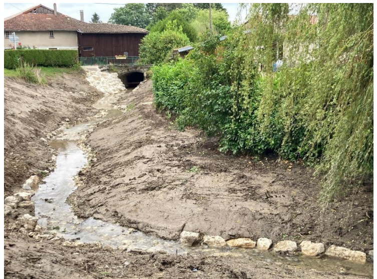
Vue depuis l'extrême amont de l'ancienne zone de remous sur le lit du Giberme aménagé.
