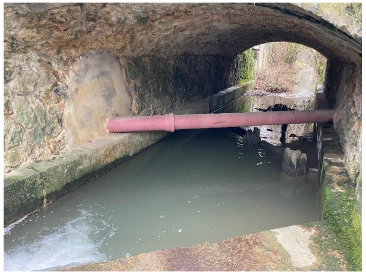
Le Gibermé en aval du vannage sous la RD 63.
