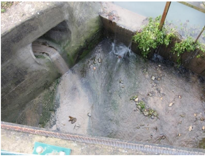
Sortie d'eaux pluviales au droit du radier du vannage (rive droite en amont du pont de la RD 63).
