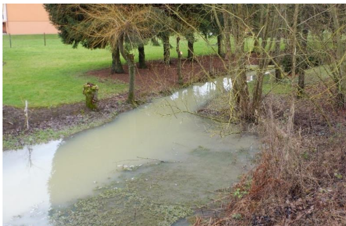
Zone de remous hydraulique de l'ouvrage supérieure 80 m en hautes eaux.
