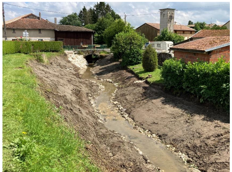
Création d'un lit d'étiage sinueux avec variation des faciès d'écoulement (radiers-fosses-plats courants).
