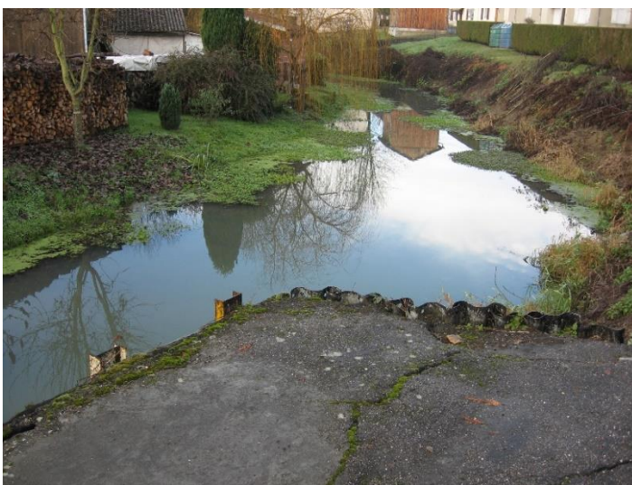
Vue sur le remous de l'ouvrage depuis l'aval (mars 2013).
