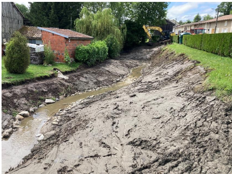
Les bordures de banquettes ont dû être maintenues par une rangée de blocs et concassé calcaire : maintien des matériaux argilo-vaseux. Ensemencement des berges et banquettes.
