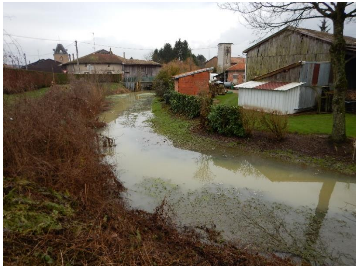
Vue sur le remous de l'ouvrage depuis l'amont (hiver 2015).
