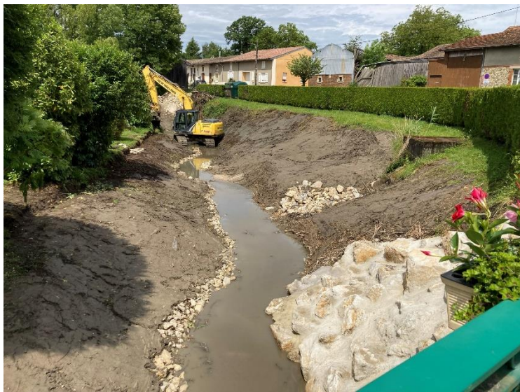
Finalisation de l'aménagement du lit d'étiage. Vue sur le ruisseau depuis le pont de la RD.
