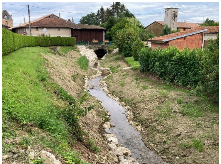
Le Giberme 1 mois après travaux.
