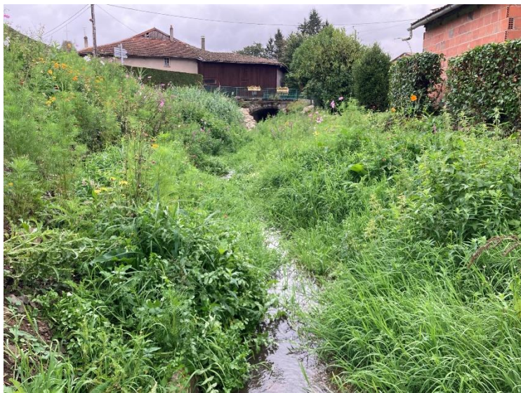
Avec la belle végétalisation du site, des habitats piscicoles sont déjà disponibles seulement 3 mois après travaux.
