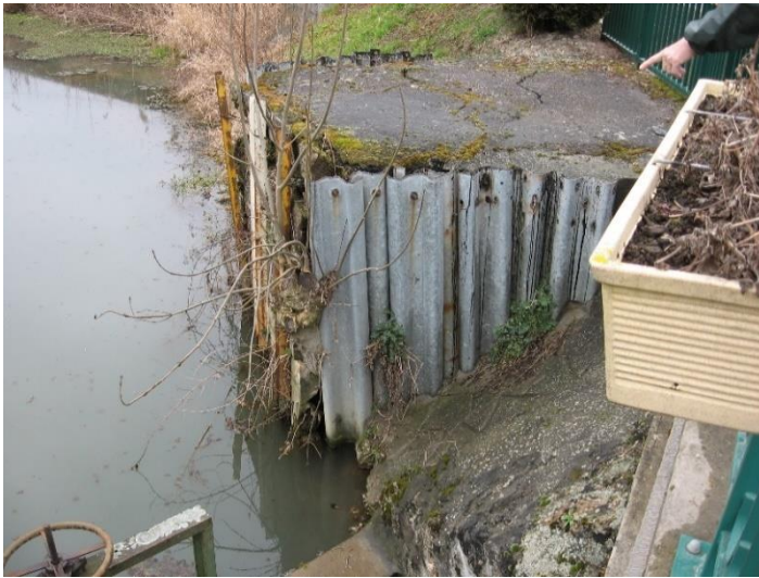
Ancienne plateforme d'accès pompiers à la réserve incendie (mars 2013). Plateforme déstabilisée à dégrader dans le cadre des travaux.
