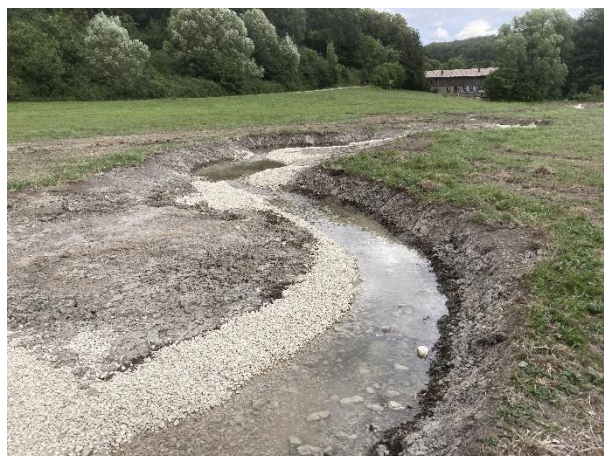
Le ruisseau après recharge granulométrique.
