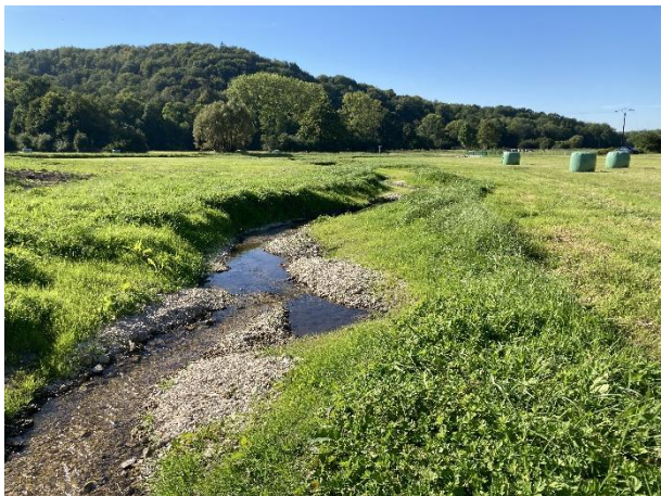
Tronçon remis en fond de thalweg 2 mois après travaux (début septembre). Les berges se sont bien revégétalisées. Quelques plantations d'arbres sont également prévues en berge à l'hiver 2023-2024.
