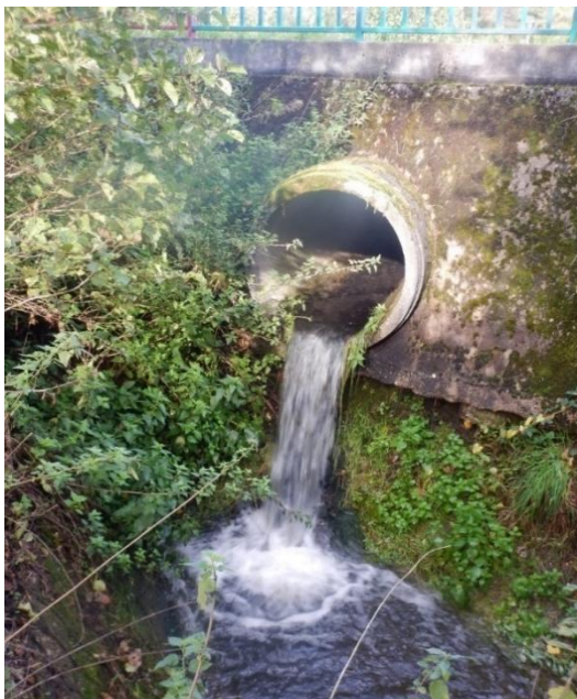
Ouvrage de franchissement de la RD 2 du ruisseau des Sept Fontaines infranchissable (hauteur de chute = 1,50 m). Erosion régressive remontée jusqu'à l'ouvrage RD 2 suite au redressement au 18 ème siècle de la Biesme et à son incision engendrée.
