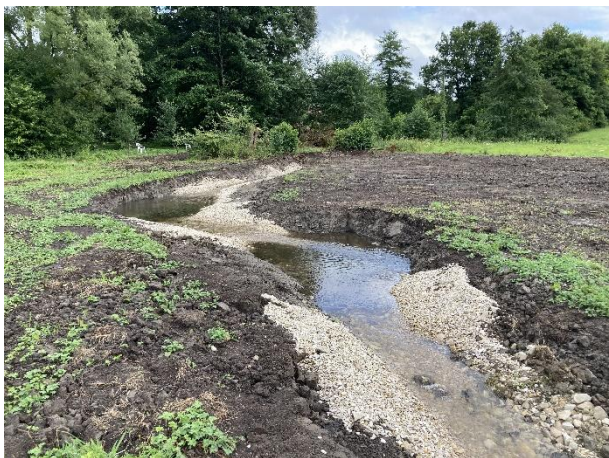
Tronçon amont du nouveau lit remis en fond de thalweg.
