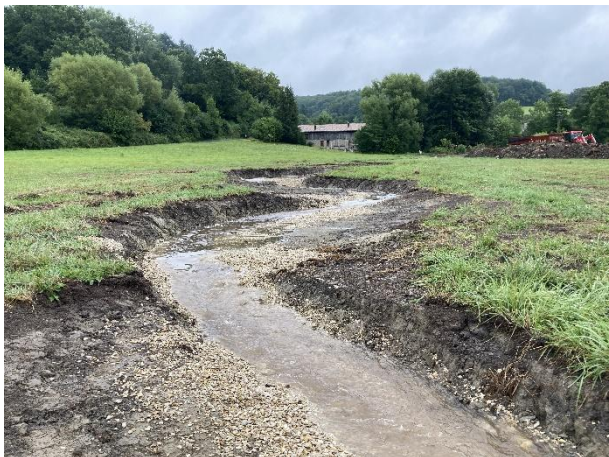
Autre point de vue sur le nouveau lit du ruisseau après recharge granulométrique.
