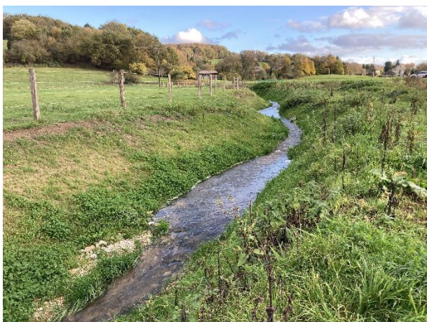
Tronçon du ruisseau entre la route communale et la RD 2 au mois de novembre (4 mois après travaux).
