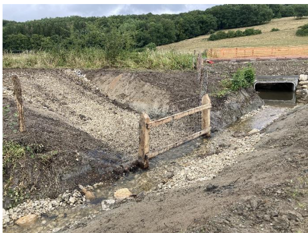
Une descente aménagée a également dû être créée pour permettre l'abreuvement de l'âne qui pâture en rive droite avec une chèvre. Une clôture a également été posée.
