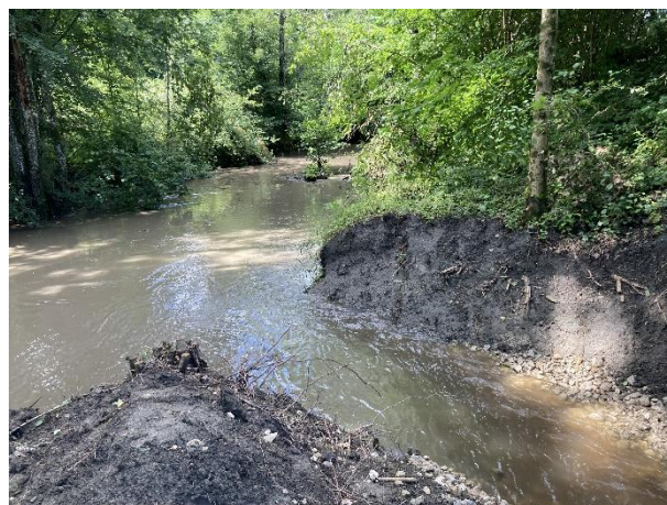
La confluence après un fort épisode orageux juste après travaux. En hautes eaux, une partie de l'extrême aval du ruisseau au droit de la confluence se retrouve ennoyé ; favorisant d'autant plus la remontée du poisson sur ce tronçon du ruisseau aval à la RD 2 à la pente moyenne encore marquée.
