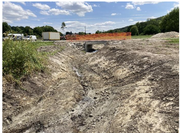
Façonnement également du lit du ruisseau entre la voie communale et la RD 2. Sur ce tronçon un fossé était déjà existant. Il convenait de refaçonner un lit de cours d'eau aux formes et faciès diversifiés et aux cotes souhaitées du fond du lit.
