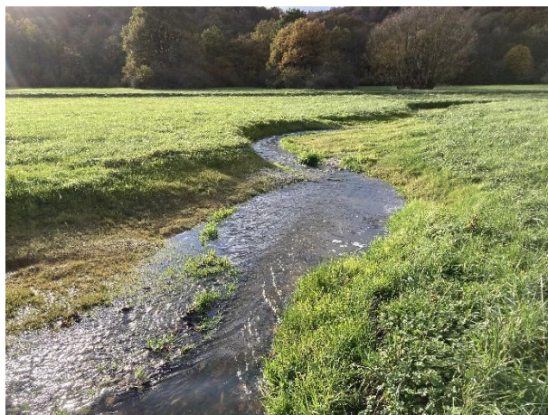
Tronçon remis en fond de thalweg 4 mois après travaux (novembre 2023).
