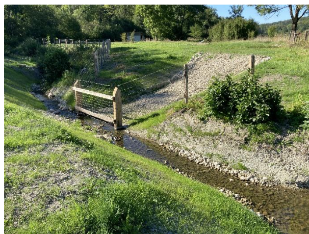
La descente aménagée 2 mois après travaux.
