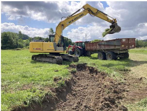
Après la pose des ouvrages d'art, les travaux de façonnement du lit du ruisseau des Sept Fontaines en fond de vallée ont pu débuter.
