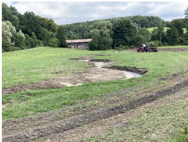
Vue d'ensemble du tronçon remis en fond de thalweg après travaux.
