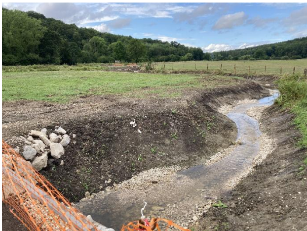
Le tronçon du ruisseau entre la voirie communale et la RD 2 après recharge granulométrique (vue depuis le pont de la route communale).
