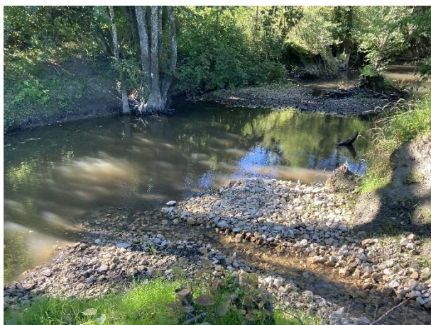
La confluence avec la Biesme. Un cône de déjection a été créé au droit de la confluence (2 mois après travaux).
