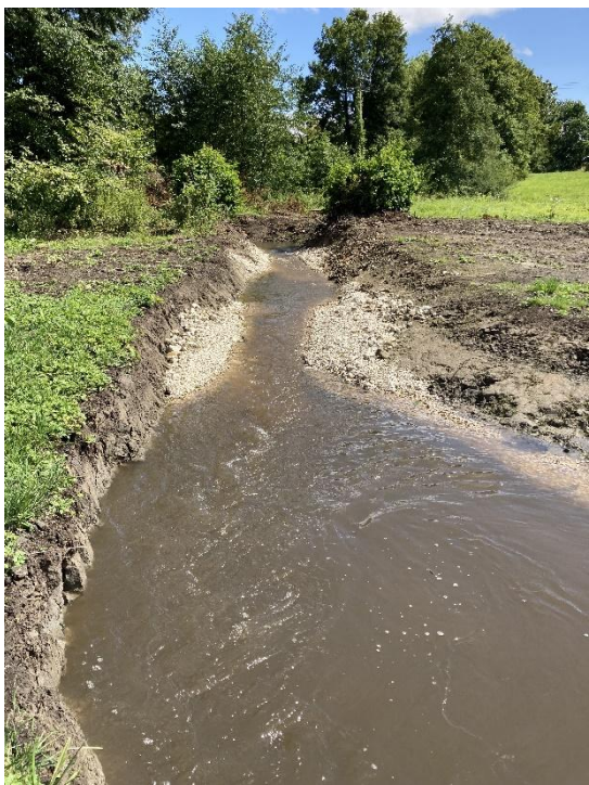
Le ruisseau après de forts orages à la fin des travaux. Vue sur la partie extrême amont du lit remis en fond de vallée.
