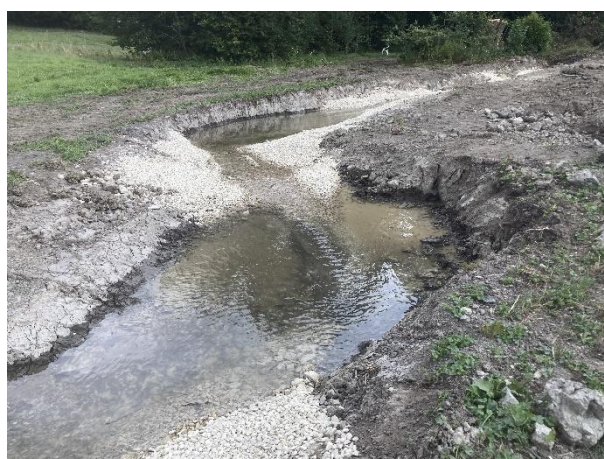
Le ruisseau après recharge granulométrique.
