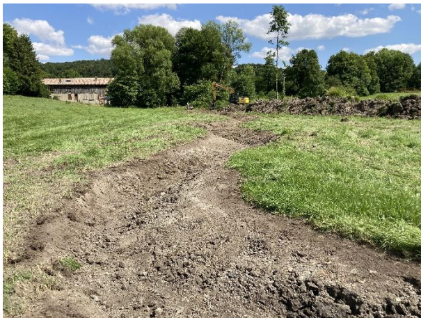
Façonnement du nouveau lit du ruisseau au gabarit, à la sinuosité et aux faciès souhaités.
