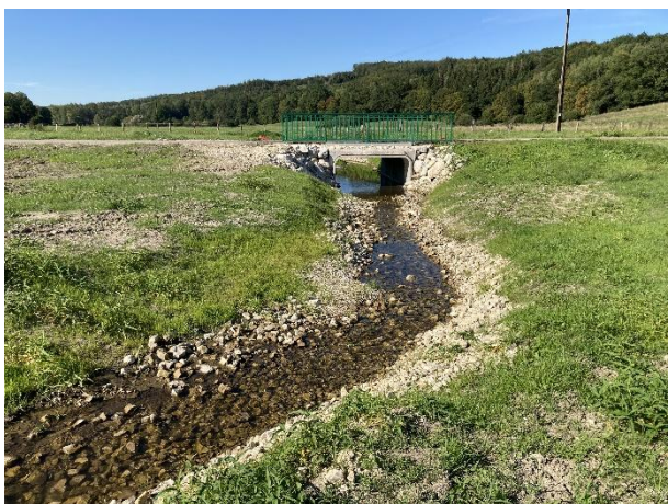
Tronçon remis en fond de thalweg 2 mois après travaux, en amont du pont de la route communale (début septembre).
