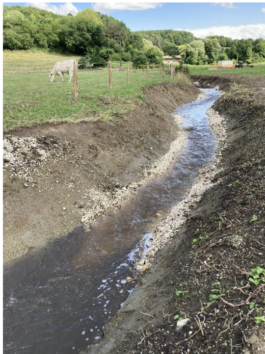
Le tronçon du ruisseau entre la voirie communale et la RD 2 sur sa partie aval après recharge granulométrique et un épisode pluvieux.
