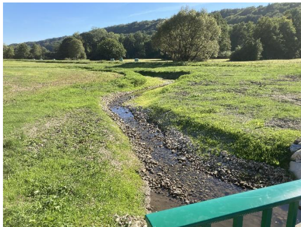
Vue depuis le pont de la route communale sur le tronçon remis en fond de thalweg dans la prairie, 2 mois après travaux.
