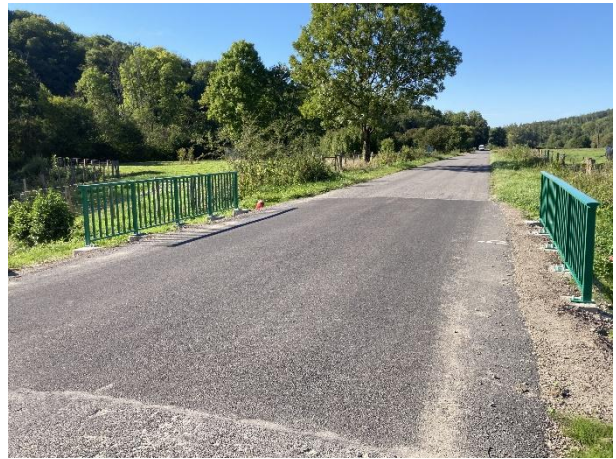
Pont de la RD 2 après pose des garde-corps.
