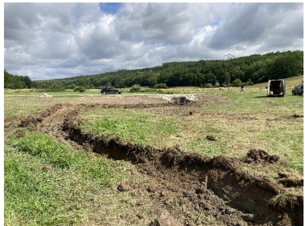
Premiers terrassements du nouveau lit en fond de thalweg. En arrière-plan l'ouvrage de la voie communale.
