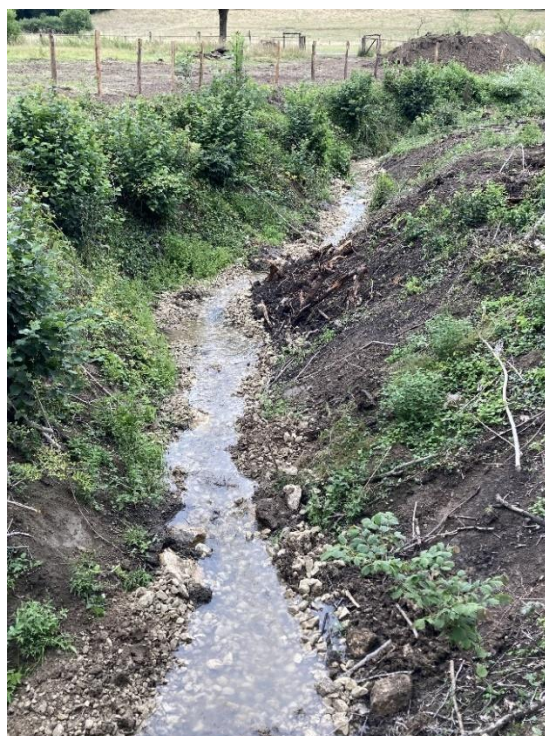
Tronçon aval à la RD 2 après recharge en concassé 40-150 cm.
