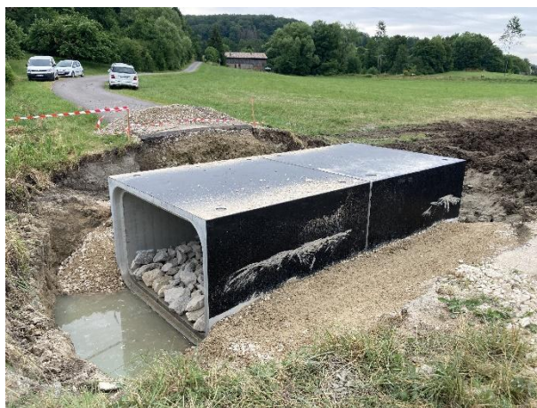
Autre point de vue sur l'ouvrage de franchissement de la route communale en cours de mise en œuvre. L'intérieur du pont cadre a été tapissé de blocs non gélifs sous la cote du futur fil d'eau du ruisseau.
