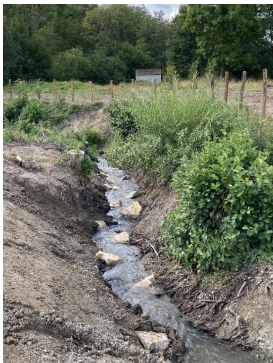
Le tronçon du ruisseau entre la voirie communale et la RD 2 après recharge granulométrique (vue depuis le pont de la route communale).
