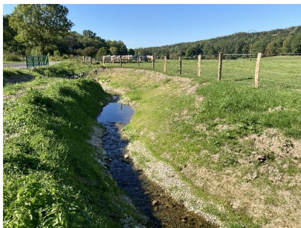
Tronçon du ruisseau entre la route communale et la RD 2, 2 mois après travaux (début septembre).
