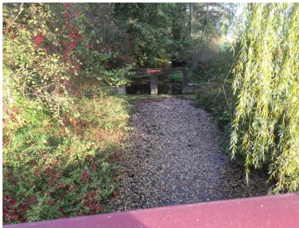
20 m en amont du vannage, la Biesme franchit le pont de la RD 603. Le remous de l'ouvrage est supérieur à 400 m !
