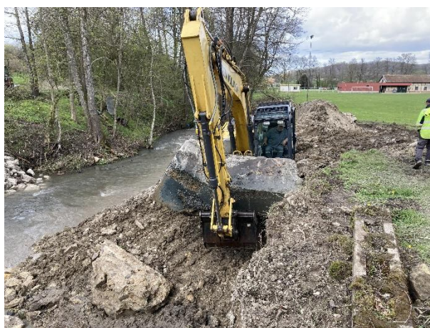
Evacuation en décharge des blocs béton démantelés.
