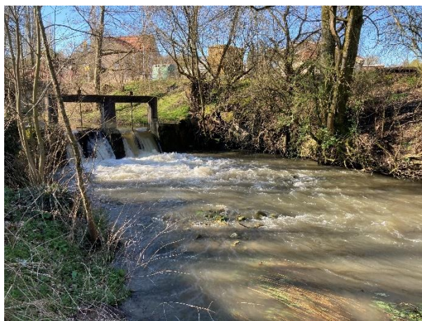
Autre point de vue aval sur le vannage en hautes eaux.
