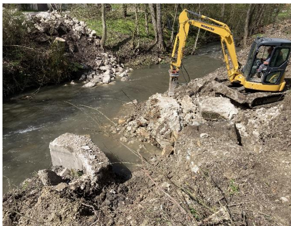
Démantèlement de toutes les fondations et du radier béton à la pelle hydraulique munie d'un brise-roche hydraulique.
