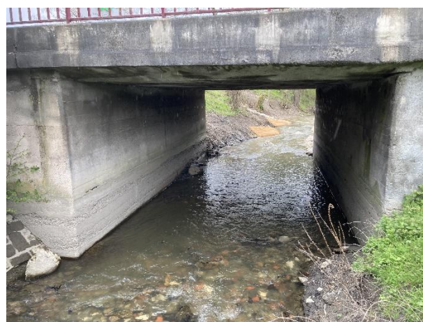
L'ouvrage RD 603 demeure franchissable suite au dérasement du vannage.
