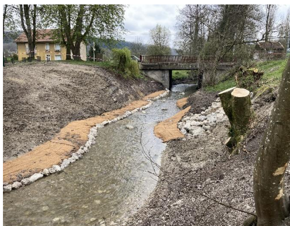
Après travaux de dérasement de l'ouvrage, les berges abruptes ont été refaçonées et des banquettes créées pour former un lit d'étiage. Les sorties de pluviales ont été également réaménagées.
