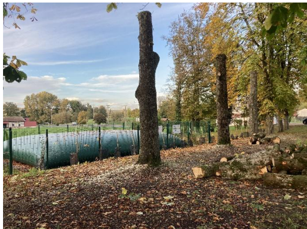
Avant travaux de dérasement du vannage et du radier, une réserve incendie de type citerne souple de 120 m 3 a été installée sur le terrain communal jouxtant en rive droite le vannage ; afin d'assurer la protection incendie de la commune suite à l'effacement de cet ouvrage inscrit au SDIS 55.
