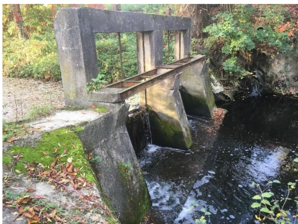
Vannage de la réserve incendie des Islettes sur la Biesme. Hauteur de chute d'1 m.
