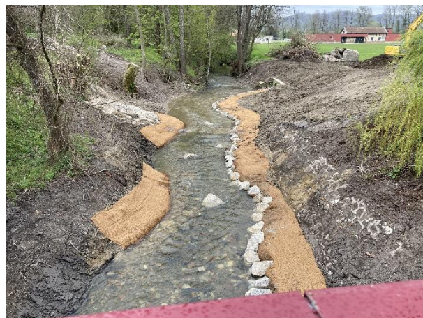
Vue depuis le pont de la RD 603 sur le lit de la Biesme réaménagé après travaux
