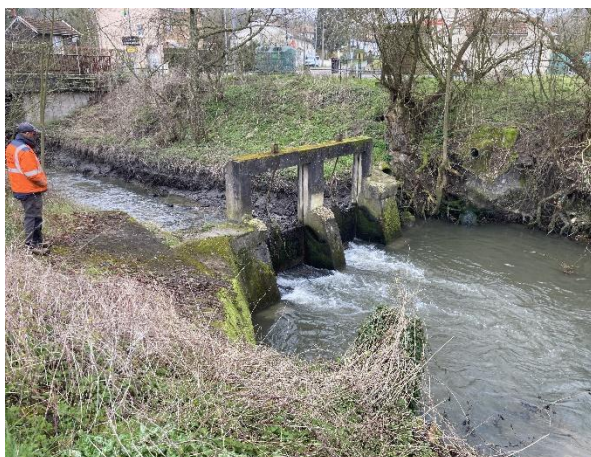
Ouverture progressive des vannes sur plusieurs jours en avril 2023 pour éviter un départ trop important et rapide des sédiments accumulés en amont de l'ouvrage.
