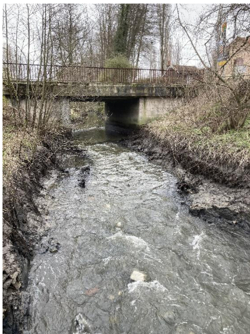
Vue sur l'ouvrage RD 603 et l'ancienne zone de remous après dérasement de l'ouvrage.
