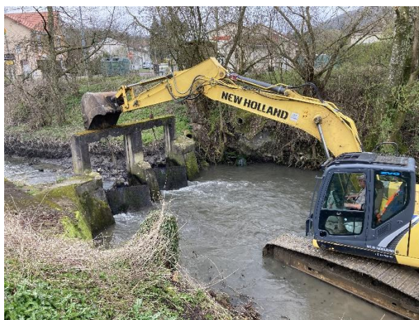
Démantèlement de l'ouvrage à la pelle hydraulique.
