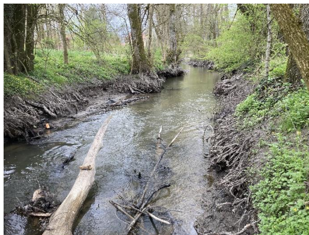
Redynamisation des écoulements avec transit sédimentaire aussitôt les travaux de dérasement de l'ouvrage réalisés. Des variations de faciès sont déjà perceptibles (radiers/mouilles/plats courants). Les racinaires d'aulnes implantés en berges créent des resserrements ponctuels du lit mineur et faciliteront d'autant plus la diversification des écoulements sur cet ancien bief chenalisé et permettront la création rapide d'abris sous-berges.
