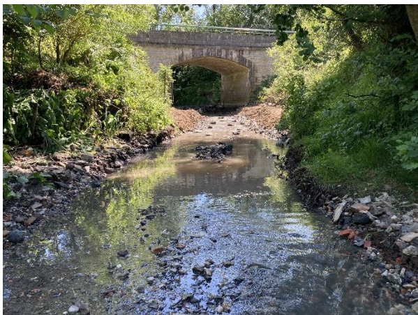
Vue reculée depuis l'aval sur le site restauré. Après le radier au droit du seuil effacé, une fosse puis un nouveau radier naturel s'enchaînent.
