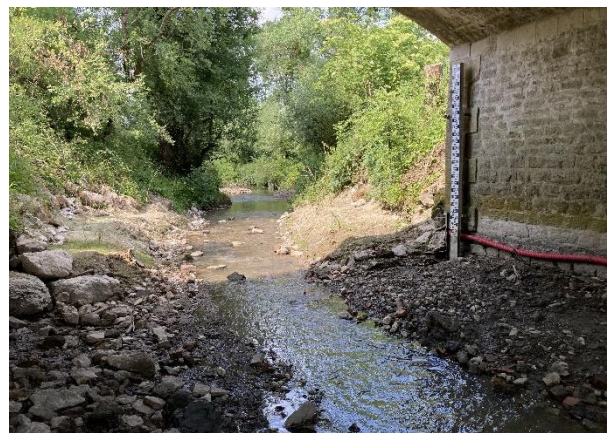
Lit d'étiage sous l'ouvrage après dérasement du seuil.
