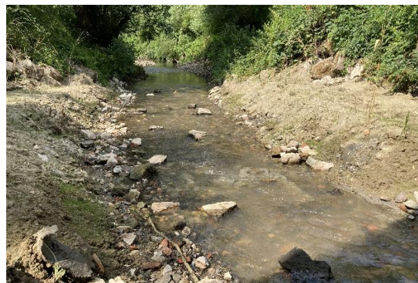
Radier aval au pont RD 84 après dérasement de l'ouvrage, 1 mois après travaux.
