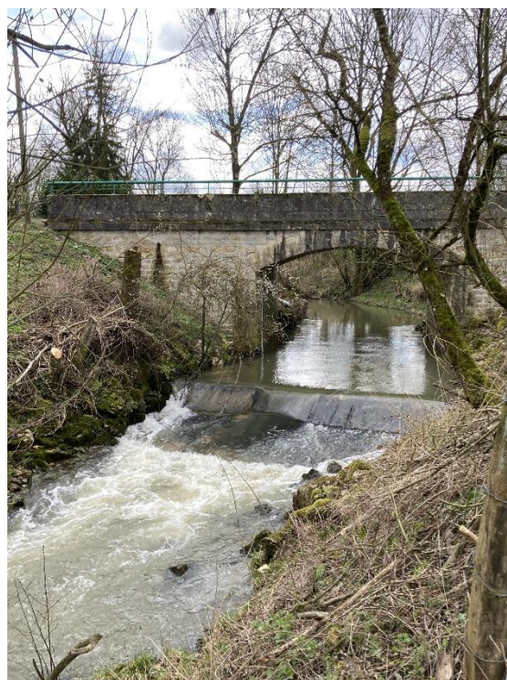
Seuil jaugeur vu depuis l'aval, avec en arrière-plan le pont de la RD 84.
