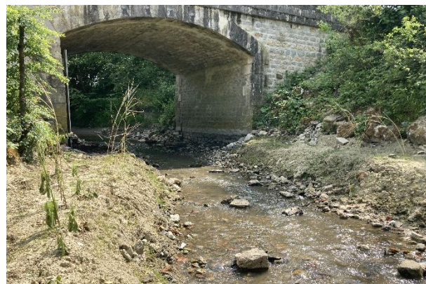
Autre point de vue sur le radier et l'ouvrage RD 84.
