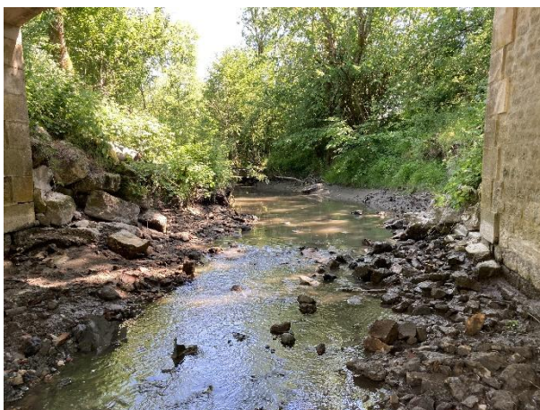
Vue sur la Biesme en amont de l'ouvrage. Abaissement de la ligne d'eau, mais un léger remous demeure avec le radier du pont fait de blocs divers. Le profil de la Biesme devrait néanmoins évoluer après les hautes eaux.
