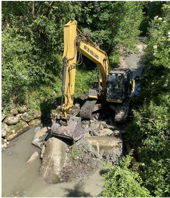
Dérasement du seuil à la pelle hydraulique. L'encaissement du lit nécessite une intervention dans le lit. Mise en place d'un filtre MES dans le cours d'eau en aval du site.
