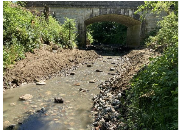
Après dérasement de l'ouvrage, réaménagement du lit mineur. Les enrochements gélifs latéraux sont recouverts de terre végétale puis ensemencés. Quelques blocs issus du lit sont disposés sur le radier.
