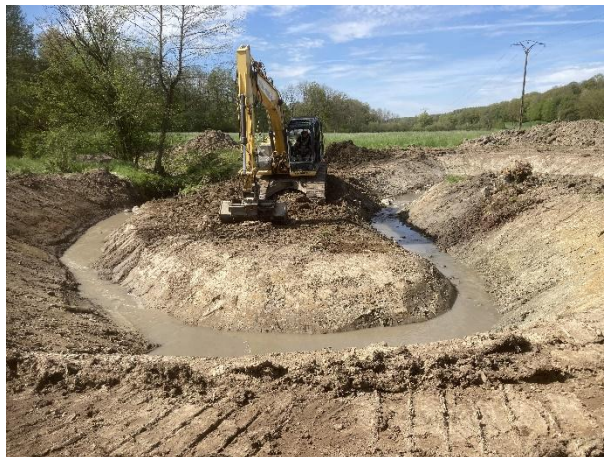
Façonnement du second méandre avec préformation de la pente moyenne et des faciès.
