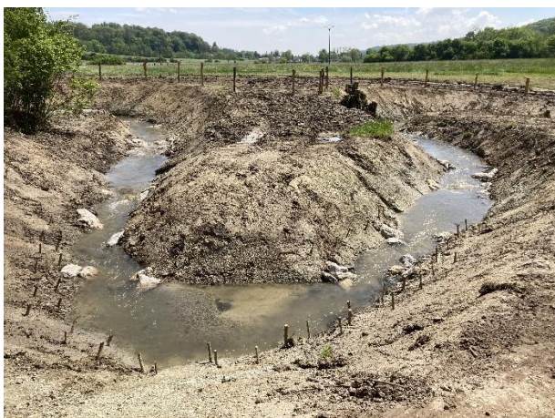
Après aménagement des faciès, des boutures sont plantés au pied des berges pour stabiliser berges mais aussi permettre au futur racinaire de participer à la diversification des faciès d'écoulement, la stabilisation de la pente et créer des habitats piscicoles.
