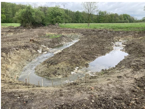
Après façonnement des méandres, des radiers de fond sont créés au sein des méandres avec des blocs non gélifs et du concassé 80-200 cm ; intercalés de fosses de dissipation ou de plats courants avec disposition de blocs épars. L'objectif premier de ces aménagements est de stabiliser la pente du ruisseau pour assurer dans le temps sa franchissabilité car la pente moyenne demeure encore marquée après travaux (1,25%). Les turbulences et successions de faciès avec zones rapides (radiers et plats courants) et zones plus lentes (mouilles) assureront la franchissabilité multi-espèces du ruisseau ; tout en créant une diversité d'habitats.
