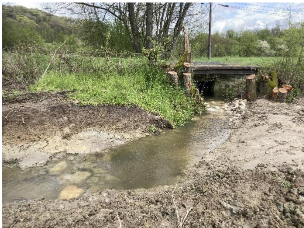
Le ruisseau après reconnexion au 1 er méandre façonné et comblement de l'ancienne fosse. La hauteur de chute du 1 er seuil racinaire (80 cm de chute) est rattrapée.
