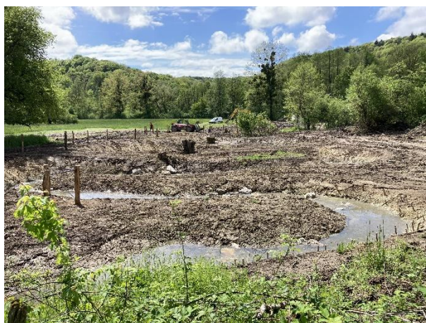
Vue sur le nouveau lit du ruisseau très méandriforme après travaux. On perçoit au centre des souches d'aulnes et saules conservées qui correspondent à la ripisylve de l'ancien lit comblé.
