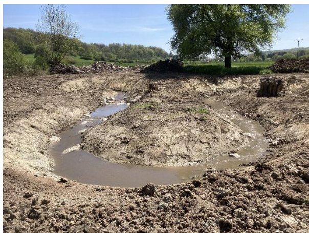
Sur ce méandre, s'enchaînent de l'amont vers l'aval : un radier, une fosse, un plat courant avec blocs disposés en quinconce, une nouvelle fosse au point d'inflexion du méandre, un nouveau plat courant, une fosse et un nouveau radier de fond en sortie du méandre. Les faciès sont très rapprochés pour casser la dynamique du ruisseau et les vitesses d'écoulements sur une pente moyenne encore marquée.
