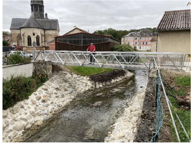
Vue sur la passerelle en aluminium et platelage bois.
