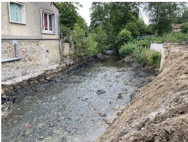
Vue sur l'ancien remous après dérasement du seuil amont.
