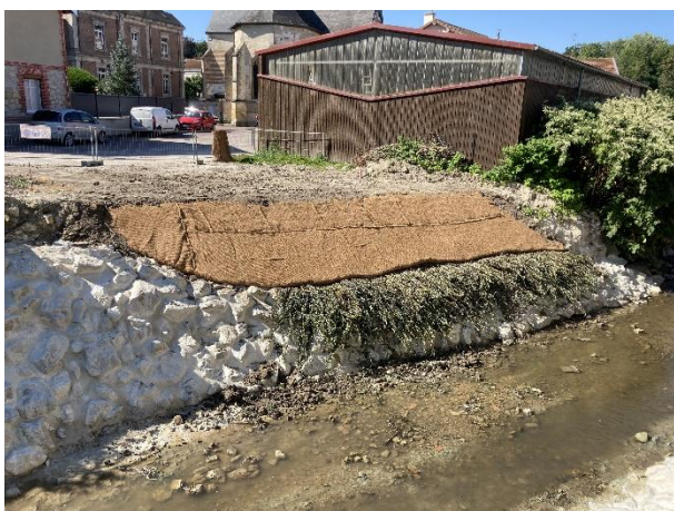
Protection de berge de rive gauche aménagée avant mise en place de la nouvelle passerelle.
