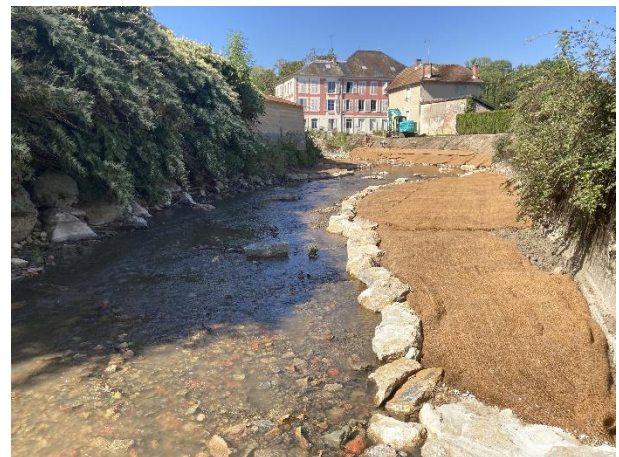
Vue vers l'aval du lit de la Biesme réaménagé entre l'habitation de l'ancien moulin et le pont de la RD 63.
