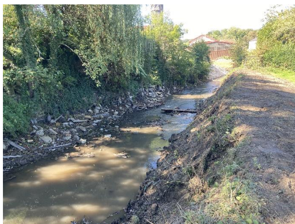
Ancien bief du moulin après effacement du seuil. Plats courants, radiers et quelques fosses apparaissent au sein de l'ancien remous. Le cours d'eau demeure encaissé au sein de cet ancien bief qui ne correspond pas au lit d'origine de la Biesme. En effet, le thalweg de la Biesme est situé en contrebas des jardins de rive droite ; mais cet ancien lit est actuellement comblé et en partie urbanisé.
