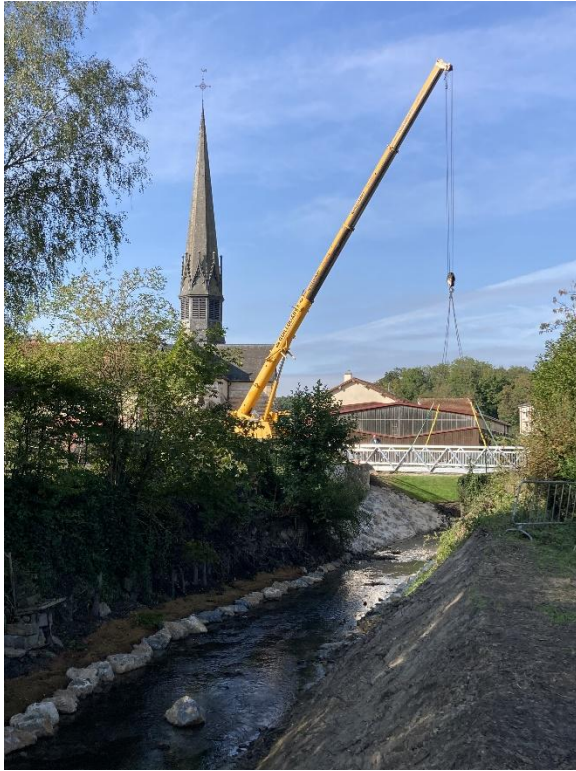
Mise en œuvre d'une nouvelle passerelle piétonne adaptée à l'élargissement avec le retalutage en pente douce de la berge gauche. Nouvelle passerelle longue de 14 m.
