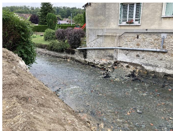
Lit de la Biesme après dérasement du seuil amont et du muret maçonné de rive gauche.
