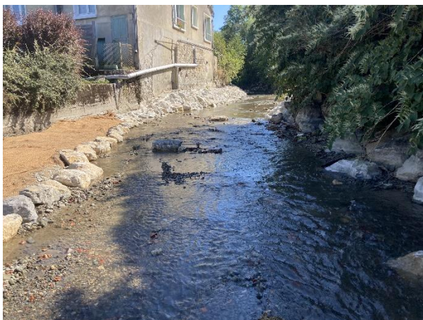
Vue sur la Biesme après aménagement du lit à l'aval de l'ancien seuil du moulin : radier avec blocs de diversification et banquette végétalisée en rive droite ceinturée d'une rangée de blocs pour assurer sa stabilité.
