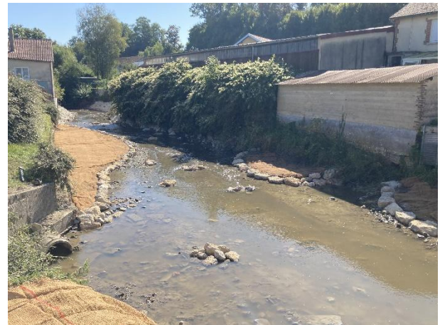
Le petit seuil aval a également été dérasé puis le lit réaménagé jusqu'au pont de la RD 63 (80 ml). Entre les deux seuils dérasés, le lit de la Biesme forme désormais un long radier diversifié. Le lit mineur de la Biesme dans la traversée du bourg entre l'habitation de l'ancien moulin et le pont de la RD 63 a été resserré par l'aménagement de grandes banquettes végétalisées en alternance rive gauche rive droite pour donner une sinuosité au lit de la Biesme en s'adaptant aux infrastructures latérales (muret, sortie de lavoir, ...). Des blocs épars ont également été disposés dans le lit pour accroître davantage la diversification des faciès. Sur les 80 ml entre l'habitation de l'ancien moulin et le pont de la RD 63, se succède un long radier, une « future » fosse puis un plat courant.
