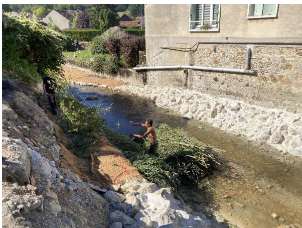
Mise en œuvre d'un enrochement liaisonné sur toute la berge droite bordant afin de consolider et protéger les fondations de l'habitation. La rive gauche au droit du muret dérasé est également stabilisée par un enrochement liaisonné en pied de berge ; le milieu et le haut de berge sont retalutés en pente « douce » avec mise en œuvre d'un lit de plançon au-dessus de l'enrochement puis un ensemencement du haut de berge.
