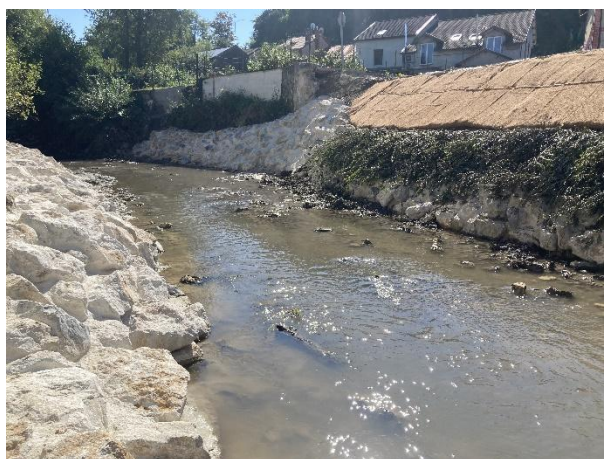
Vue sur l'aménagement des berges au droit de l'ancien seuil, avant pose de la nouvelle passerelle piétonne.
