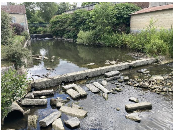
Vue sur les deux seuils faisant obstacle à la continuité écologique dans la traversée de Vienne-le-Château. Hauteur du seuil aval = 45 cm. Hauteur du seuil amont = 140 cm (chute d'eau 1,20 m en étiage).
