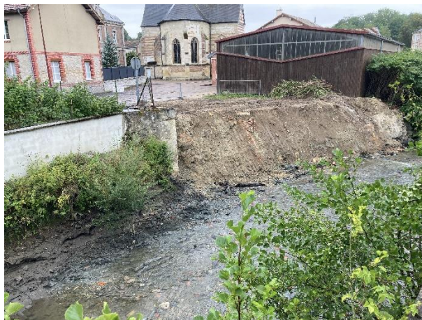
Vue sur le muret de rive gauche dérasé au droit du seuil de l'ancien moulin.
