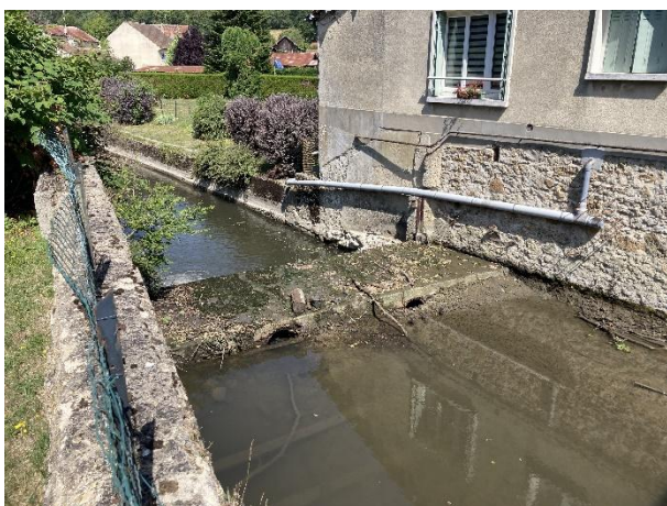
Vue sur le seuil amont après dégagement des deux buses situées dans le seuil ; et sur l'habitation qui borde la rivière en rive droite.
