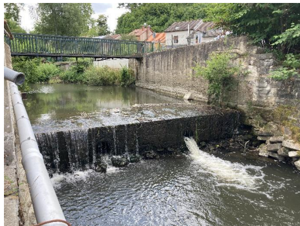
Seuil de l'ancien moulin de Vienne-le-Château. En rive droite, une habitation borde la rivière ; en rive gauche, un muret maçonné borde la Biesme.
