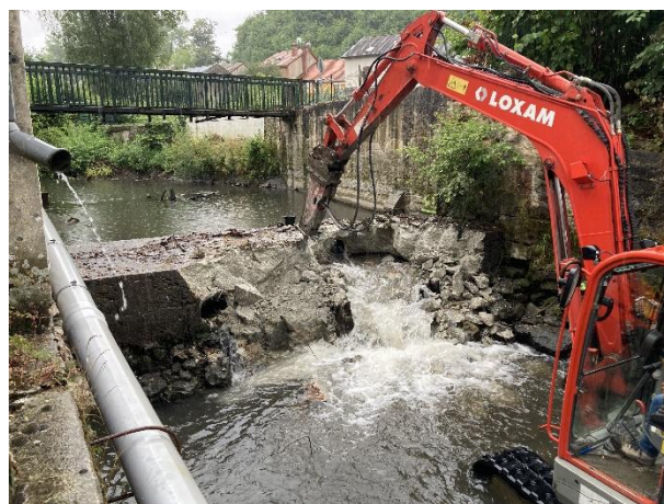
Dérasement du seuil amont au BRH.
