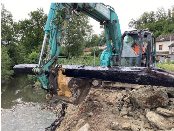
Dégagement d'anciennes poutres transversales au cours d'eau sur lesquelles était construit l'ancien moulin.
