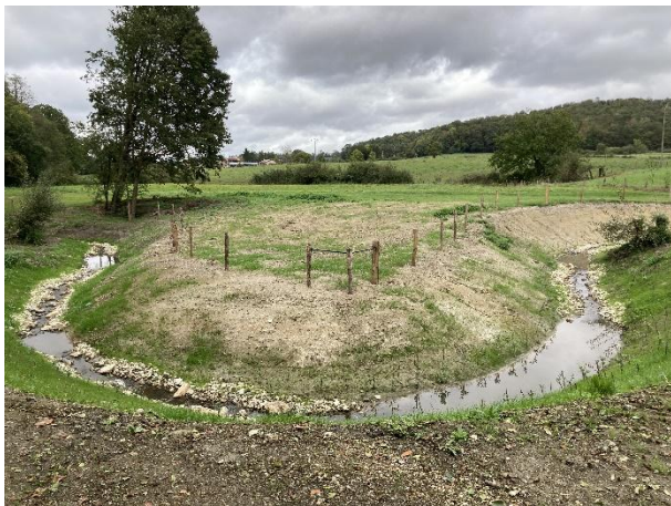
Vue sur le second méandre, 1 mois après travaux. Reprise des boutures et pousse des graminées.
