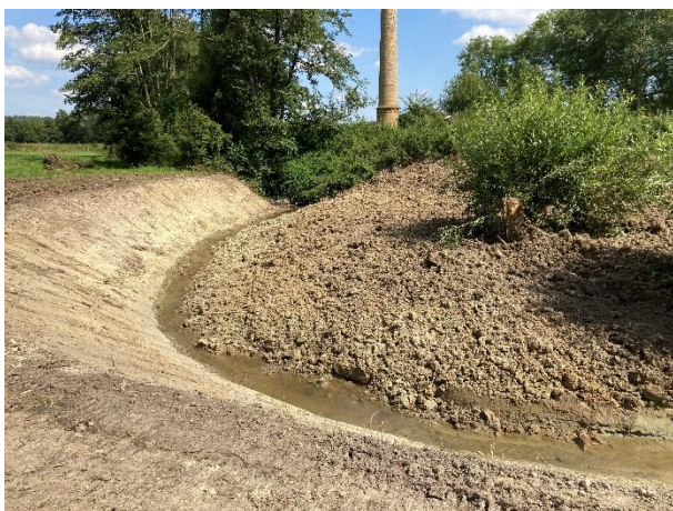
3 amples méandres ont été façonnés pour créer le nouveau lit sinueux. L'ancien lit rectiligne est lui entièrement remblayé. Photos du 1 er méandre façonné. L'encaissement marqué de la Biesme lit à son ancien redressement, génère forcément un nouveau lit du Parfonrupt encaissé vu que ce tronçon se situe à la confluence de la Biesme. Les convexités des méandres sont terrassées en pente douce quand c'est possible pour ouvrir le lit et créer une berge douce.
