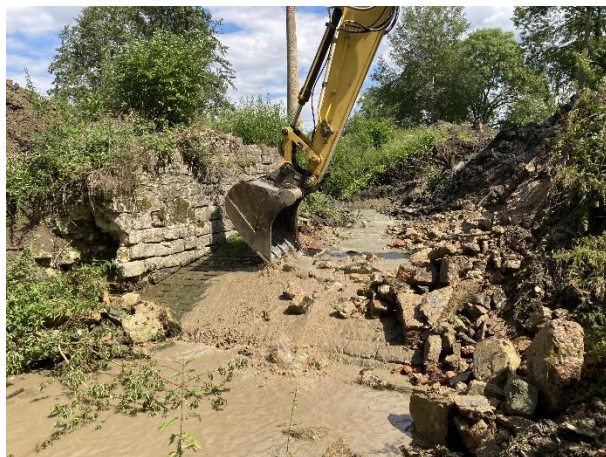
Dérasement du seuil de l'ancienne briqueterie de Parfonrupt, avant terrassement d'un nouveau lit sinueux de 120 ml pour rattraper la hauteur de chute de l'ouvrage et maintenir une pente moyenne de 1,1 % .
