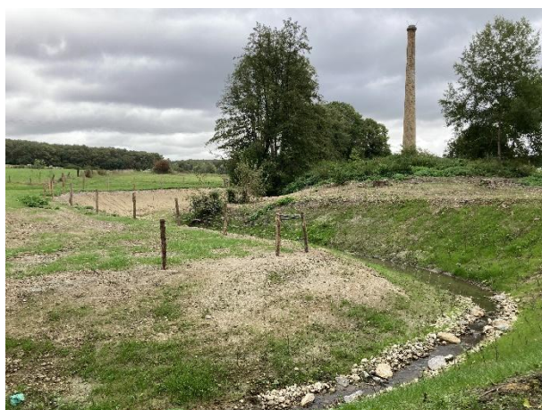
Vue sur le 1 er et second méandre 1 mois après travaux. En arrière-plan on perçoit la cheminée de l'ancienne briqueterie.
