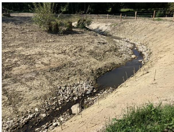
Après terrassement du nouveau lit, des radiers de fond alternant avec des fosses ont été aménagés dans le lit afin de stabiliser la pente moyenne du nouveau lit, dissiper la dynamique du cours d'eau et diversifier les habitats.
