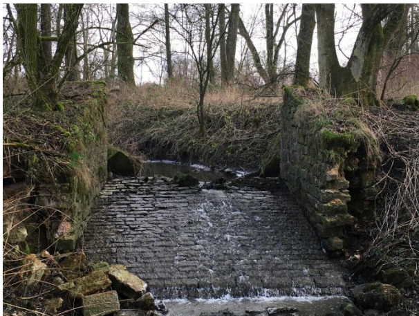
Seuil de l'ancienne briqueterie de Les Islettes faisant obstacle à la continuité écologique du ruisseau de Parfonrupt. Ouvrage situé en amont de la confluence avec la Biesme. Chute d'1,30 m.
