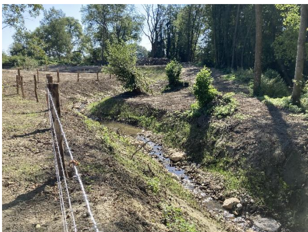
Dernier méandre avant confluence avec la Biesme (vue vers l'amont). Une clôture a été implantée sur toute la rive droite du nouveau lit afin d'éviter toute dégradation des aménagements par le bétail pâturant.
