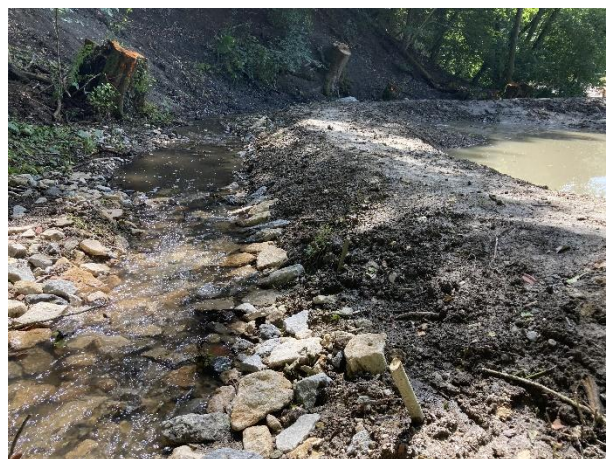
Vue de l'amont du méandre façonné.
