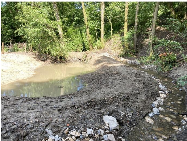
Vue sur le méandre créé et la mare réalisée au droit de l'ancienne fosse de dissipation. La digue séparant mare et méandre a ensuite étéensemencée et bouturée.
