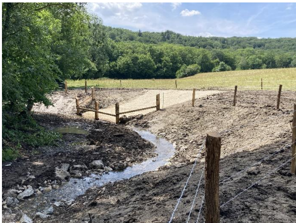
En sortie du méandre une descente aménagée a été réalisée et le lit resserré en créant une large banquette en rive gauche, recréant ainsi un nouveau méandre.
