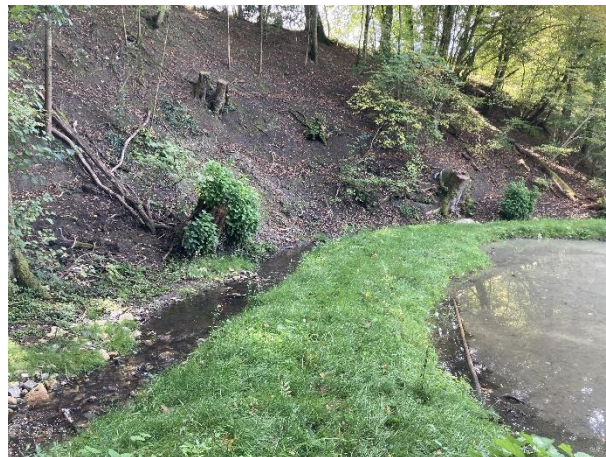
La diguette séparant mare et méandre s'est également bien revégétalisée et les boutures ont bien repris.
