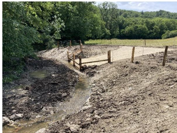
Autre point de vue sur la descente aménagée. Une clôture à barbelés a également été posée sur toute la rive droite où le bétail avait libre accès au cours d'eau.
