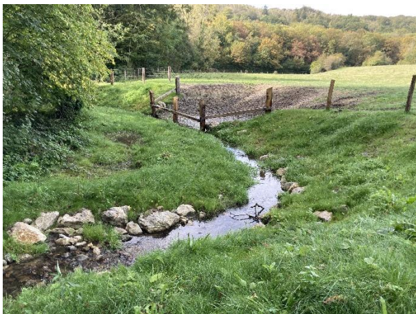
Site 4 mois après travaux (octobre 2023). Végétalisation dense des banquettes et des berges.
