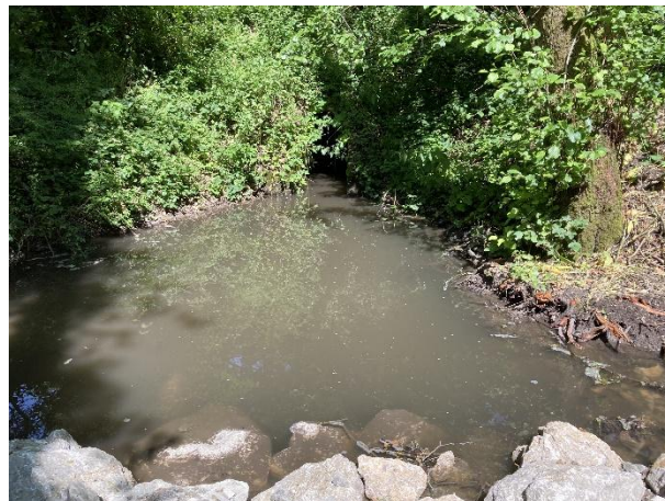
Vue sur l'ouvrage RD 2 et le début du méandre à droite de la photo. L'ouvrage demeure franchissable après aménagement. Le seuil racinaire a été renforcé par la création d'une digue protégée sur l'amont par quelques enrochements et un bouturage.
