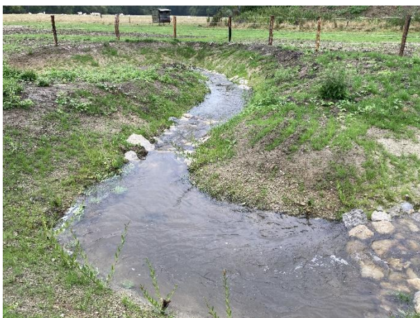
Radiers et fosses se succèdent. Quasiment Plus de 80 % de reprise des boutures et revégétalisation rapide des berges.
