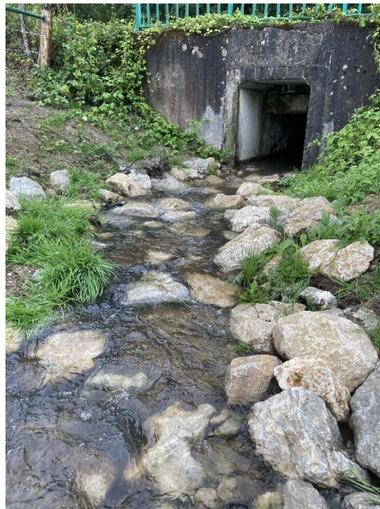
Radier en sortie de l'ouvrage, 2 mois après travaux (début août 2023).
