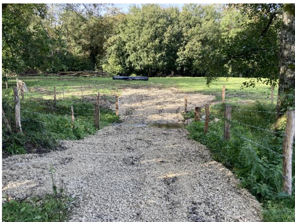
Deux passages à gué ont également été aménagés pour permettre le franchissement du bétail, leur accès aux trois prés de l'exploitant et leur abreuvement.
