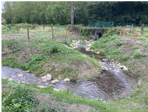
Vue sur le 1 er méandre 2 mis après travaux et le pont de la RD 2.
