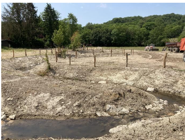
Vue d'ensemble sur plusieurs méandres après l'ensemble des travaux réalisés.
