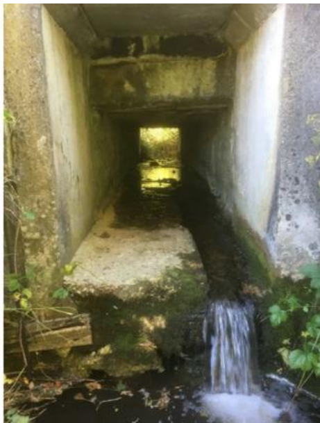
Chute de 50 cm au droit de l'ouvrage RD 2.
