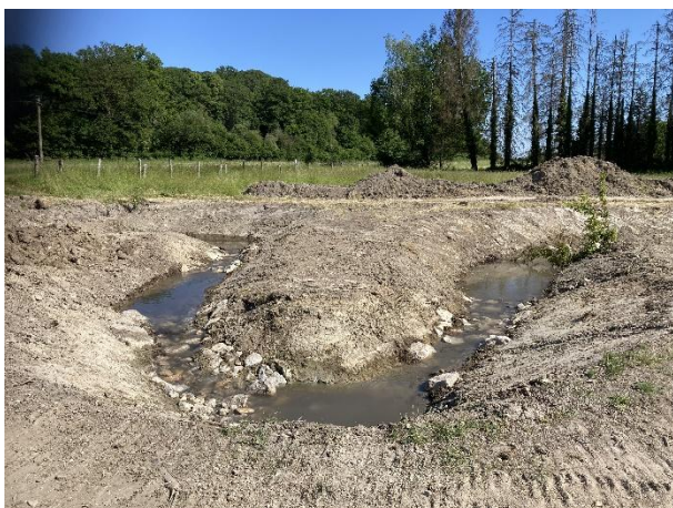
Aménagements de diversification et stabilisation du profil du lit méandré : radiers de fond, plats courants, mouilles, disposition de blocs épars. Succession des faciès assurant un maintien pérenne du profil en long souhaité de la rivière et donc de la continuité écologique du ruisseau, ainsi que de multiples habitats.
