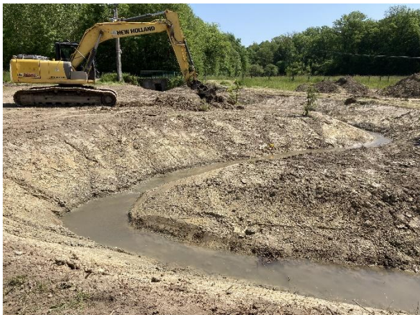
Méandre après son profilage à la pelle hydraulique et comblement de l'ancien lit. Les aménagements de diversification et de stabilisation du profil vont pouvoir être mis en œuvre.
