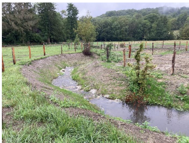
Photo 2 mois après travaux d'un autre méandre. Autant que possible, quelques arbres ou arbustes ont été conservés. Les souches recépées d'aulnes ou d'érables champêtres reprennent toutes très bien.
