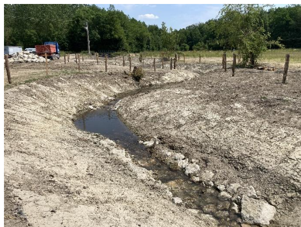
Radiers et fosses se succèdent. Les pieds de berges sont ensuite bouturés et une clôture à barbelés posées de part et d'autre du cours d'eau jusqu'à la confluence avec la Biesme.
