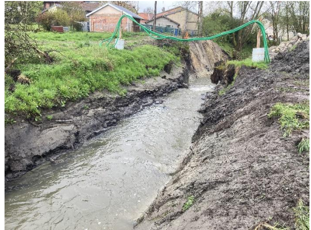
Vue depuis l'amont sur le lit du cours d'eau suite au dérasement de l'ouvrage. L'érosion régressive progresse rapidement sur un fond composé de vases compactes et argiles.
