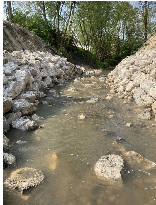
Vue depuis l'amont sur le radier façonné et les berges stabilisées au droit de l'ouvrage dérasée.
