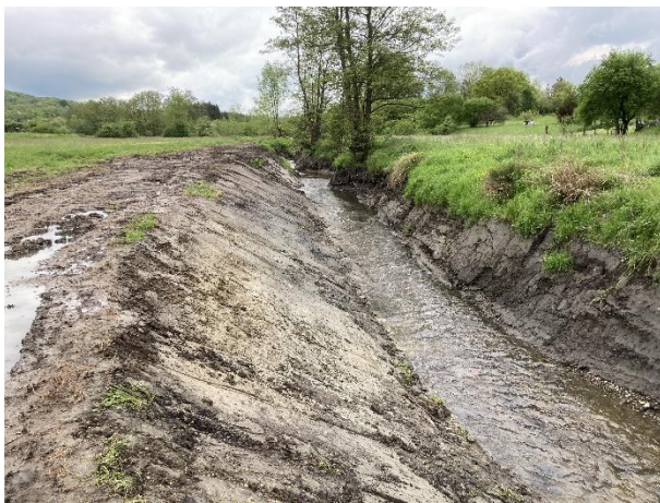
Partie amont de la berge droite retalutée et du lit reprofilé pour une pente de 0,8 %.
