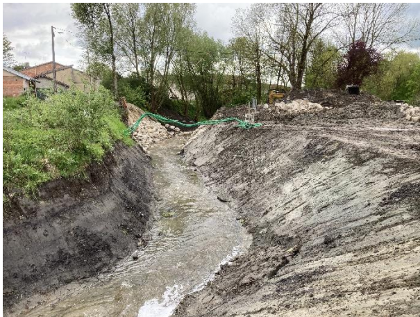
Nécessité de reprofiler le lit mineur en amont de l'ouvrage sur une centaine de mètres : pente du lit reprofilé = 0,8 % ; berge retalutées en rive droite essentiellement car berge droite verticale et située dans une ample concavité du méandre (recul du haut de berge de 1 m en rive droite).
