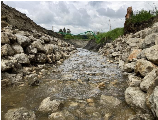
Stabilisation des berges au droit de l'ouvrage démantelé et stabilisation également du fond du lit avec la création d'un radier composés d'enrochements, de blocs et de concassés 80-200 cm. Vue depuis l'aval.
