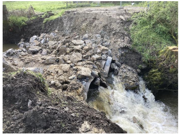
Travaux de dérasement de l'ouvrage.
