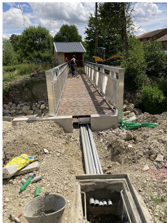
Après pose de la passerelle, des fourreaux sont mis en place sous la passerelle afin d'accueillir les réseaux de télécommunications définitifs. Ces derniers après réception des travaux seront remis en place courant septembre 2023 par Orange et Losange.
