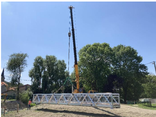
Juillet 2023 : Pose de la passerelle piétonne permettant d'assurer le franchissement du lit mineur au droit du chemin communal fortement emprunté.
