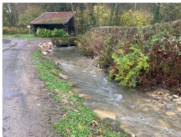
Fonctionnement hydraulique en très hautes eaux des successions de rampes aménagées en aval du pont de la « rue de l'église ». Ouvrages franchissables (vue aval des aménagements) .
