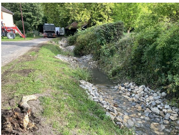
Vue depuis l'aval des 4 seuils sous forme de rampe en pente douce aménagées.
