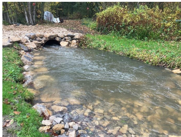
Le ruisseau de la Fontaine aux Charmes avec de gros débits en novembre 2023 à l'aval de l'ouvrage de franchissement aménagé en septembre 2023.
