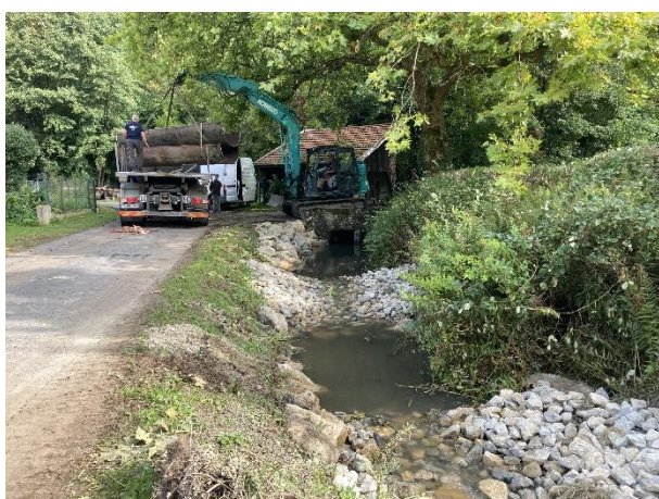
En aval du pont de la « rue de l'église », une succession de 4 seuils sous forme de rampe en pente douce de 3-4 m de longueur ont été aménagés pour rattraper les 35 cm de dénivelés infranchissables des deux buses du pont. Les rampes ont été aménagées avec des gros blocs en enrochements non gélifs en fond de fouille surmontés par du concassé 80-200 cm. Les rampes ont une forme évasée pour accroître le tirant d'eau d'étiage et les rendent franchissable en toutes conditions hydrologiques.
