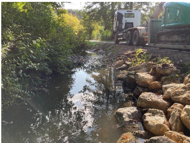
En amont du 1 er seuil, une grande fosse s'est créée. Elle vient ennoyée la buse rive droite du pont. Cette fosse sert de fosse de dissipation en sortie de l'ouvrage et de zone de repos pour les poissons en migration.
