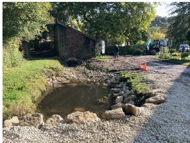
Vue depuis l'ouvrage de franchissement de l'aménagement réalisé dans l'ancien remous du vannage du lavoir : fosse en sortie de l'ouvrage et radier se poursuivant sur 5 m jusqu'au lavoir.
