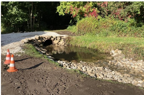
Ouvrage de franchissement aménagé suivi d'une fosse dissipation et d'un radier.
