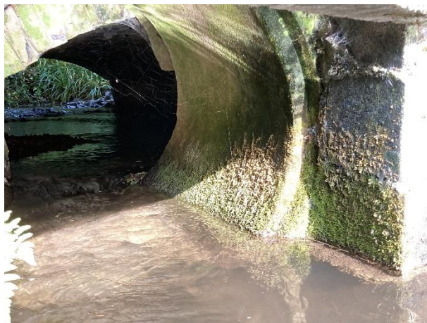
Buse ennoyée après réalisation de la 1 er seuil aval à l'ouvrage. Ennoisement ne remontant pas plus haut que l'amont de la buse, pour conserver la capacité hydraulique de l'ouvrage. Au sein du pont voûté, l'ouvrage est franchissable en étiage (tirant d'eau suffisant et pente d'1 %).
