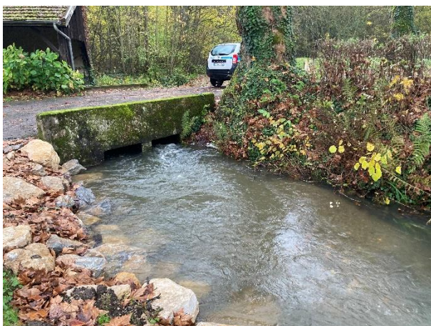
Sortie du pont de la « rue de l'église » en très hautes eaux.
