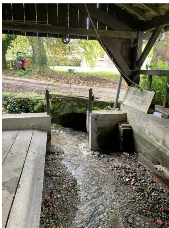
Vue depuis l'amont sur le vannage démantelé et l'échancrure faite dans le seuil du vannage. En arrière-plan on perçoit aussitôt la sortie du lavoir, le pont voûté de la « rue de l'église ».
