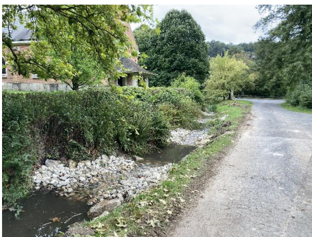
Vue depuis l'amont des 4 seuils sous forme de rampe évasées en pente douce aménagées. Entre chaque rampe s'intercale une fosse de dissipation.
