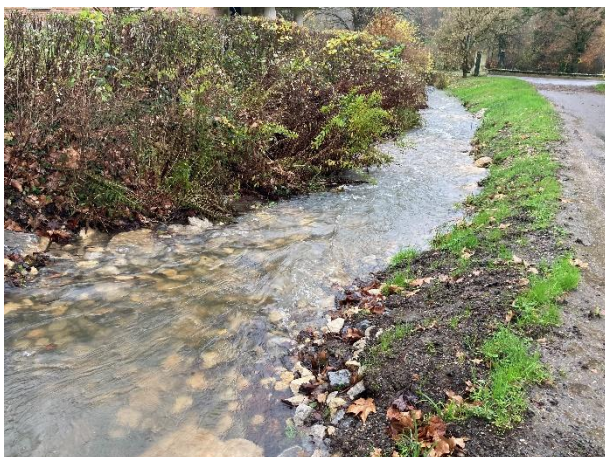
Vue amont des successions de rampes aménagées, avec des débits importants.
