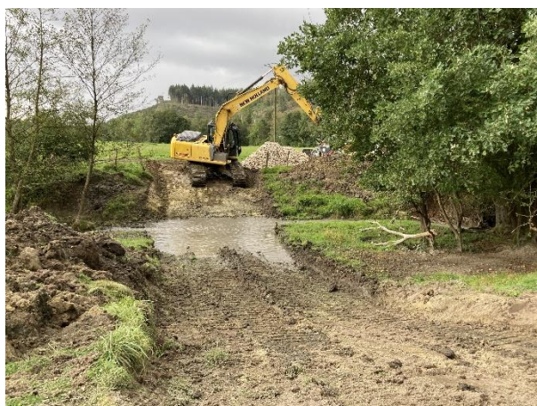
Façonnement du futur passage à gué à la pelle hydraulique.
