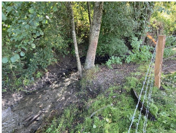
Continuité écologique rétablie après retrait des buses et démantèlement de l'ancienne passerelle. Le lit et les berges ont été légèrement reprofilés. Le ruisseau a également fait l'objet d'une mise en défens de ses berges, par la pose d'une clôture à barbelés de part et d'autre du ruisseau de la RD 67 jusqu'à la confluence avec la Biesme.
