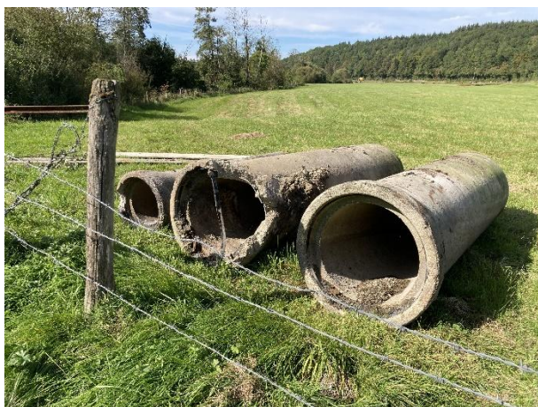
Buses retirées du lit avant leur évacuation.
