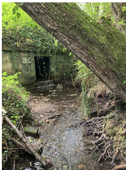
Point de vue plus large sur l'ouvrage.
