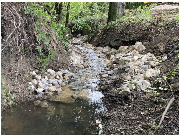
La seconde rampe en sortie de la fosse de dissipation de la 1 ère rampe.
