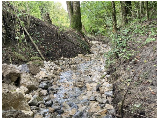
En aval de la troisième rampe, le restant du tronçon jusqu'à la confluence est rechargé avec du concassé 80-200 cm et apport de quelques blocs épars pour dissiper l'énergie du ruisseau en hautes eaux mais aussi pour resserrer et diversifier les faciès d'écoulement du ruisseau en étiage. En hautes eaux, une partie de ce tronçon aval du ruisseau se retrouve ennoyé par l'accroissement du niveau d'eau de la Biesme ; ce qui facilite la remontée du poisson sur ce tronçon demeurant avec une pente de 2 %.
