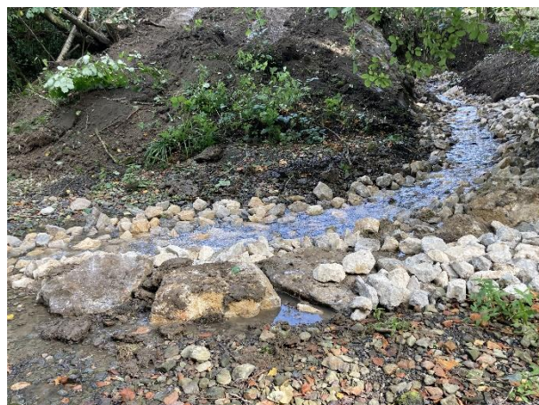
Au droit de la confluence, le lit rechargé en concassé 80-200 cm est prolongé sur l'épais banc alluvial de la Biesme présent en pied de berge droite, pour atténuer encore plus la pente. De gros blocs d'enrochements disposés au sein du banc alluvial protège le 80-200 cm d'une reprise des matériaux par la Biesme en hautes eaux.
