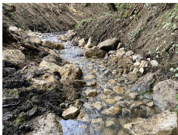
La seconde rampe en sortie de la fosse de dissipation de la 1 ère rampe.
