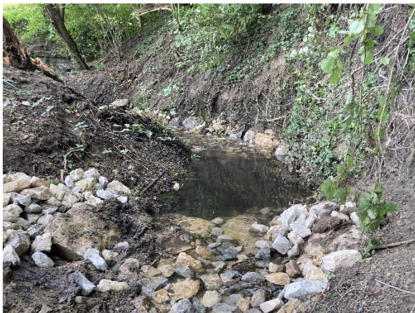
Fosse de dissipation à la sortie de la seconde rampe, avant la dernière rampe et recharge granulométrique du lit du ruisseau jusqu'à la confluence.
