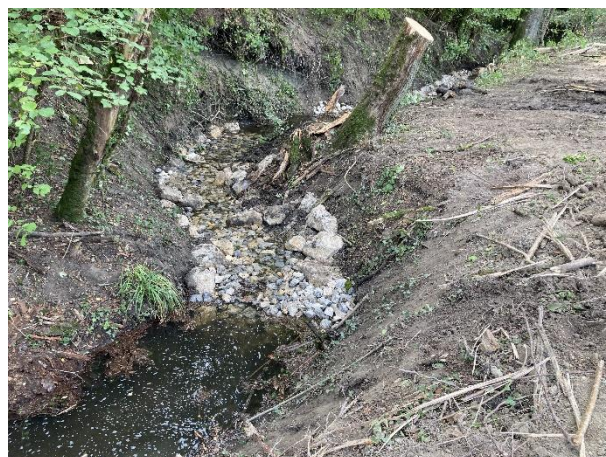
La seconde rampe en sortie de la fosse de dissipation de la 1 ère rampe.
