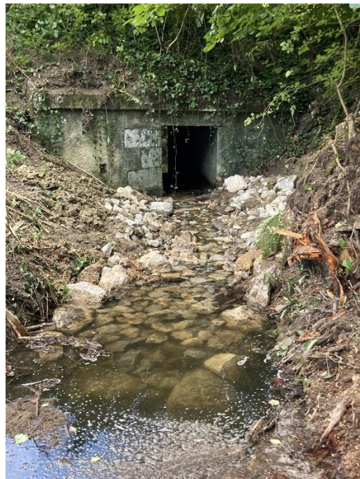
Première rampe en sortie de l'ouvrage RD 2.
