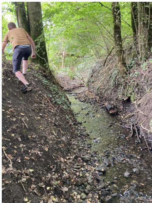
Outre l'encaissement, la pente est relativement forte entre la RD2 et la confluence : pente moyenne de 2,2 %.
