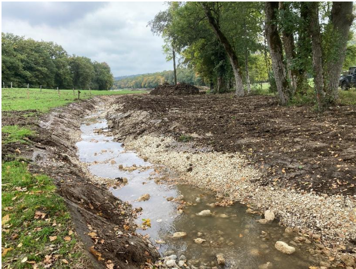
Le nouveau lit du Beauchamp à l'extrême amont du tronçon remis en fond de vallée, au niveau de la ferme, après mise en œuvre de la recharge granulométrique.
