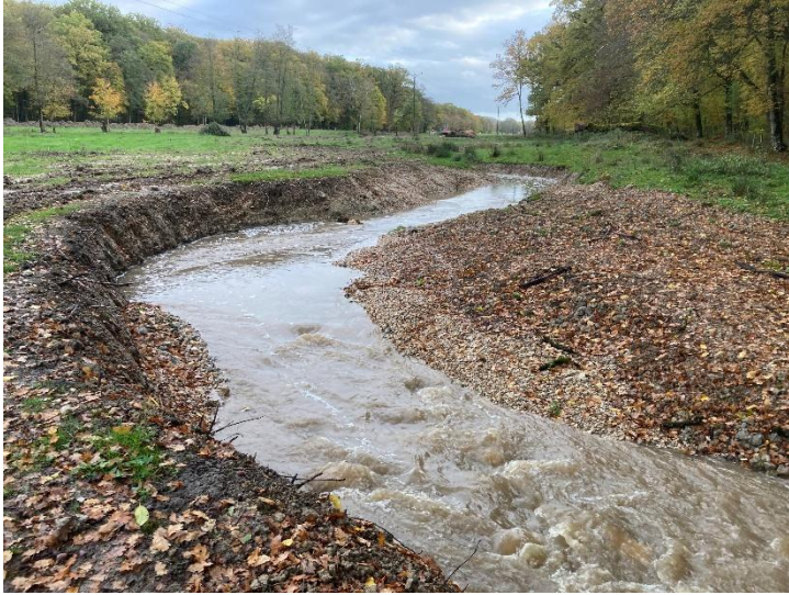
Le Beauchamp dans son nouveau lit après un fort épisode pluvieux. Turbidité liée aux travaux et berges encore à nues.
