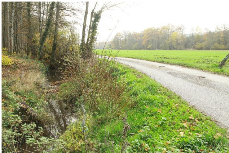
Boutures de saules plantées en berge pour consolider la berge au droit de cette encoche d'érosion.
