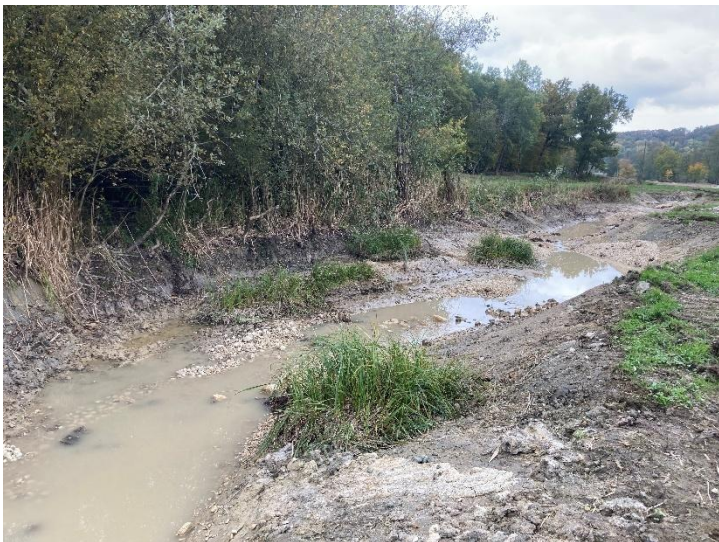
Autre point de vue sur ce tronçon en bordure de zone humide, avec notamment la création d'une banquette marécageuse le long de la saulaie.
