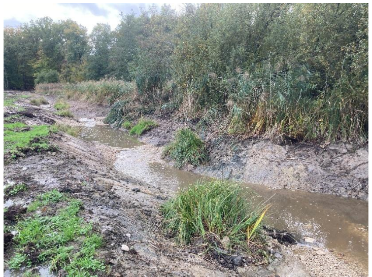
Nouveau lit du Beauchamp aux abords de la saulaie et magnocariçaie de rive gauche. Succession de fosses et radiers, des berges en pente douce avec des banquettes de carex aménagées. Tronçon du nouveau lit avec la plus faible pente (0,3 %) afin de faciliter les débordements et contribuer à une meilleure connexion entre le lit et la zone humide attenante en rive gauche (saulaie et magnocariçaie).
