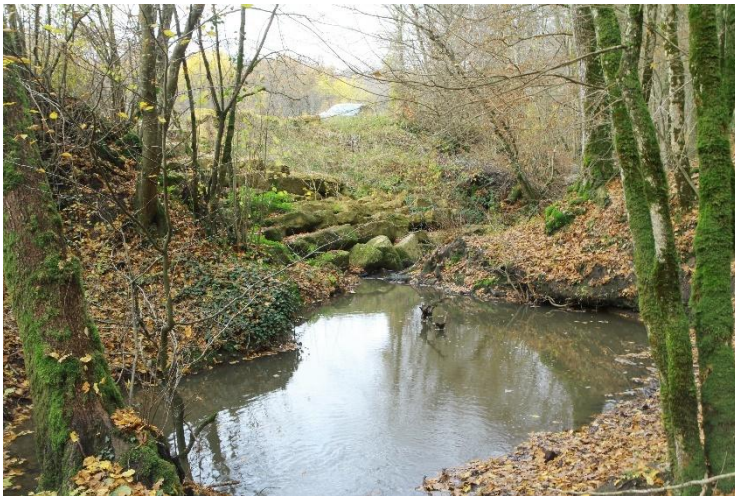
Vue depuis l'amont du lit sur ce resserrement du lit mineur et goulet d'étranglement créé par le glissement des enrochements.
