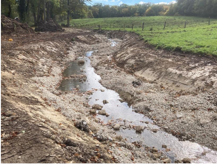
Recharge granulométrique du Beauchamp. 3 granulométries mises en œuvre pour une diversité maximale des faciès alluvionnaires : du concassé 40-80 mm, du calcaire alluvionnaire « roulé » 10-41,5 mm et des blocs 80-300 mm.
