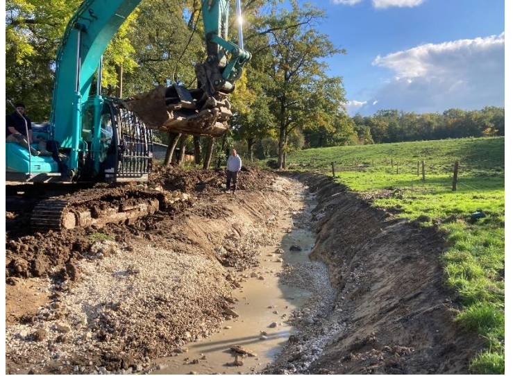
Recharge granulométrique alluvionnaire sur la partie amont du nouveau lit.
