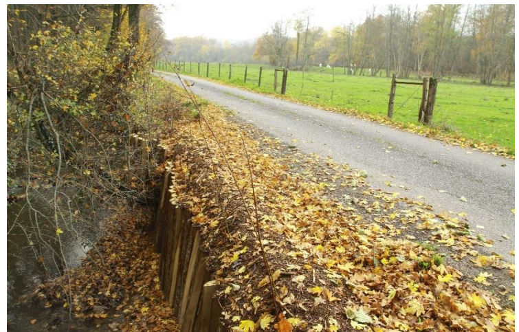
Protection de berge rustique en pieux jointifs réalisée pour consolider l'accotement du chemin sapé par le cours d'eau (secteur aval où l'encaissement du cours d'eau est moindre).
