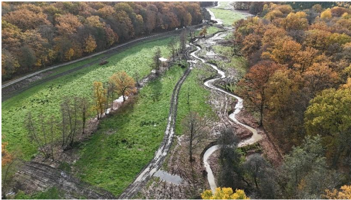
Point de vue (depuis l'aval) sur le tronçon sinueux aval du Beauchamp remis en fond de vallée après remise en eau et recharge granulométrique. On perçoit également l'ancien fossé de drainage comblé avec sa ripisylve partiellement conservée.
