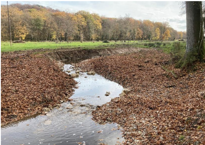
Le nouveau lit du Beauchamp après travaux de terrassement et recharge granulométrique. Les faciès d'écoulement sont très diversifiés : radiers, fosses, plats courants.
