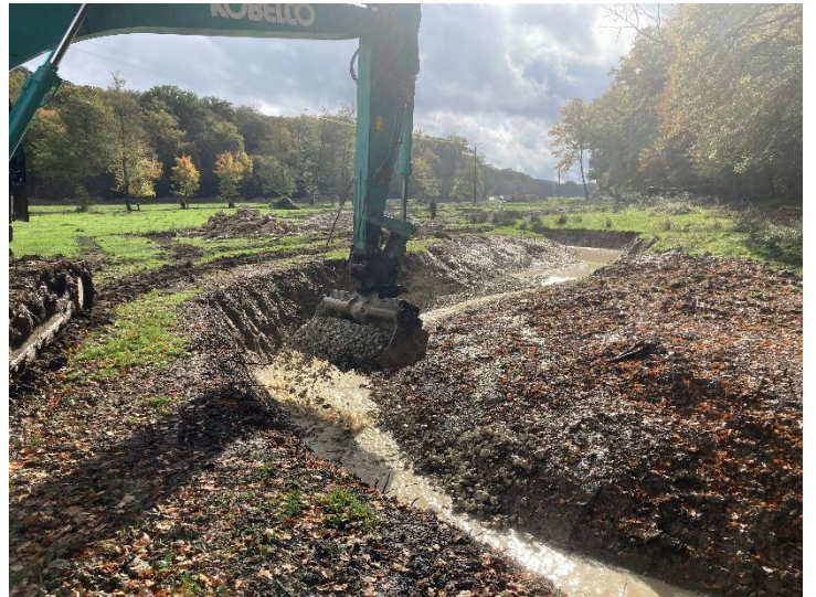
Travaux de recharge granulométrique après remise en eau du nouveau lit pour caler au mieux les radiers, bancs alluviaux, ... Ici aménagement d'un radier en sortie de fosse et de méandre.
