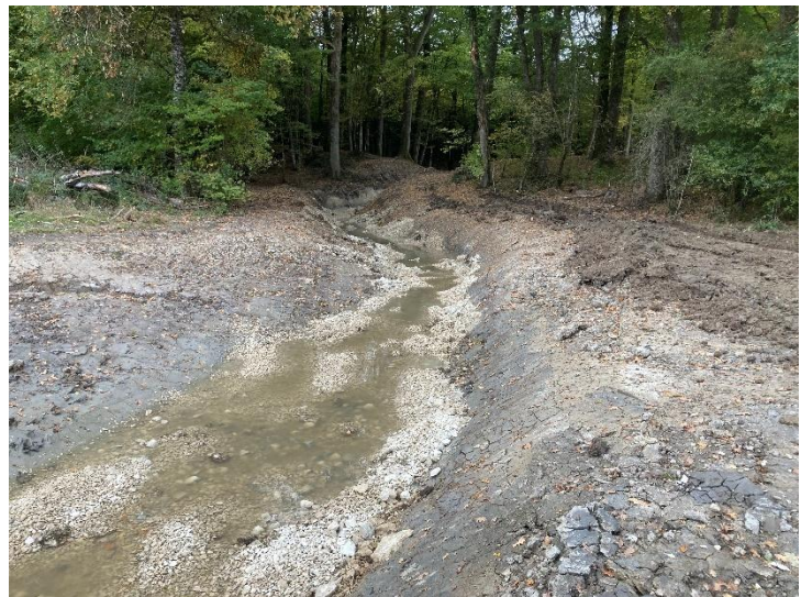
Recharge granulométrique en sortie de la traversée forestière.
