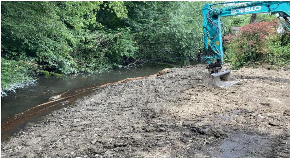
Réalisation de banquettes après dérasement de l'ouvrage. A droite, prolongement de la buse pour les eaux pluviales.
