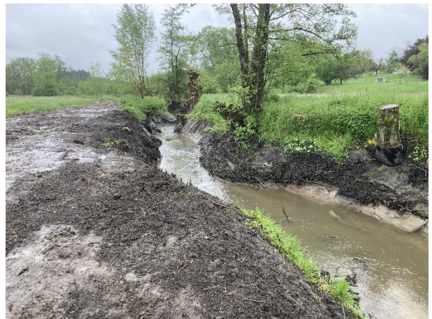
150 m en amont de l'ouvrage dérasé, forcément avec un abaissement de ligne d'eau de 2 m, la ripisylve d'aulnes et saules blancs se retrouve perchée. C'est pourquoi des boutures de saules buissonnants ont été plantées en pied de berges sur les 150 m amont à l'ouvrage pour créer une ripisylve connectée au fond du lit. Plus en amont, la révégétalisation des berges se fera naturellement.
