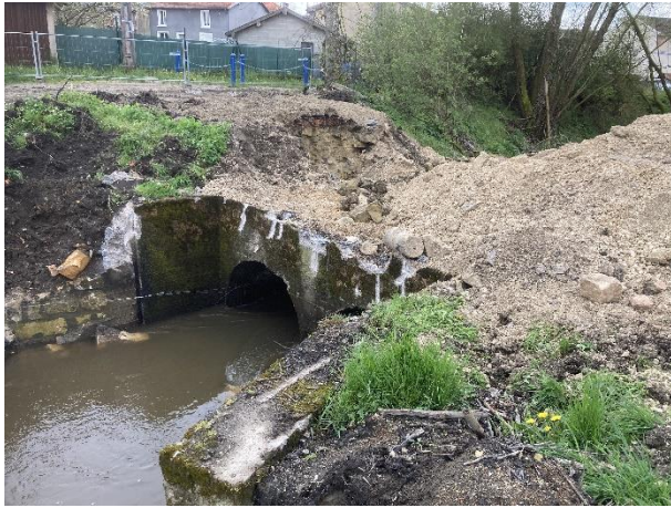
Début des travaux de dérasement de l'ouvrage en avril 2023.
