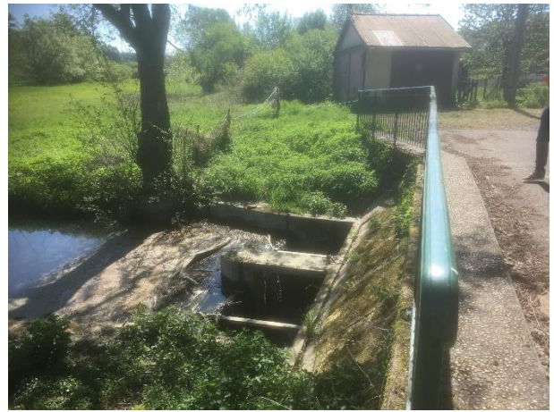
En amont de l'ouvrage, présence de deux vannes fixes d'une hauteur de chute d'1,40 m.
