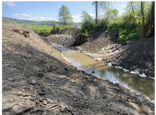
Vue sur le lit mineur du ruisseau de Beauchamp réaménagé en aval de l'ouvrage démantelé.
