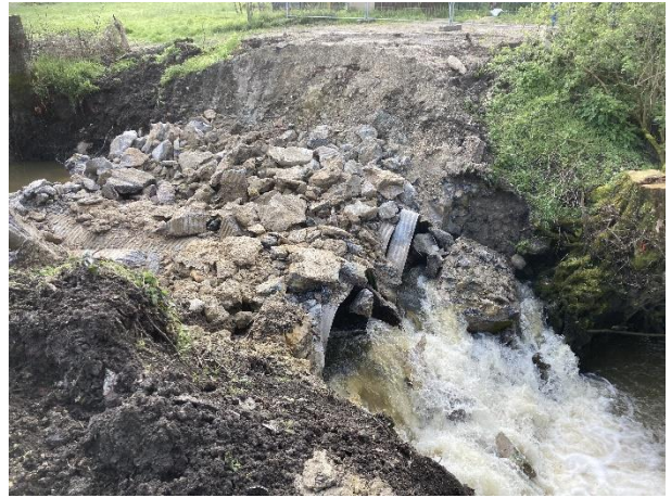
Travaux de dérasement de l'ouvrage.
