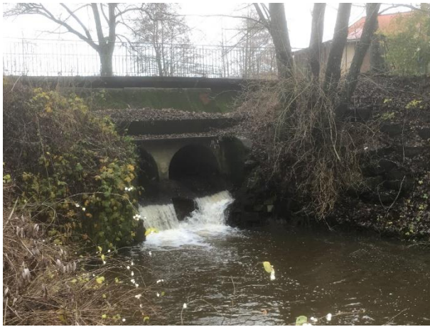
Pont du chemin de la Noue (chute aval d'1,10 m), implanté au droit d'un ancien seuil de moulin.
