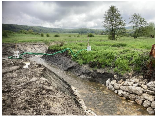
Lit mineur reprofilé vu depuis l'aval au droit de l'ancien ouvrage.
