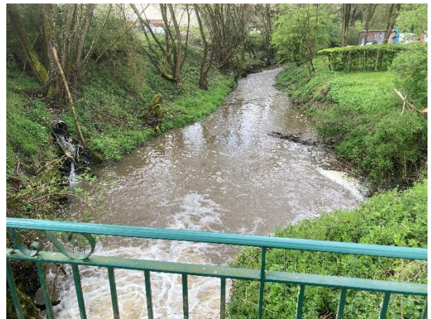
Vue sur le ruisseau de Beauchamp à l'aval de l'ouvrage. Grosse fosse de dissipation, lit encaissé et également rejet en rive gauche d'eaux usées de la commune mélangée une source captée (l'assainissement de la commune des Islettes n'est pas réalisé ; la commune est en assainissement non collectif mais seules quelques habitations sont en conformité).
