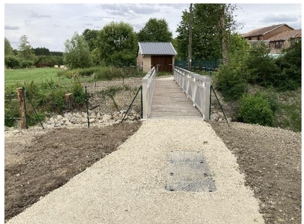
Une clôture a également été mis en place de part et d'autre de la passerelle et sur les deux rives pour sécuriser le site et le cheminement piéton.
