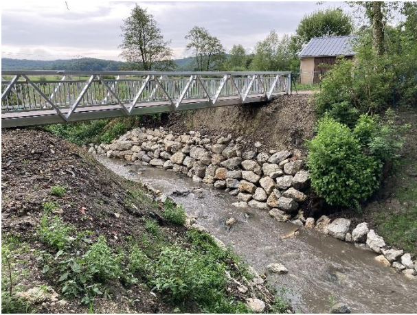
Le ruisseau de Beauchamp au droit de la passerelle et du radier sous-jacent début août après un gros épisode pluvieux.
