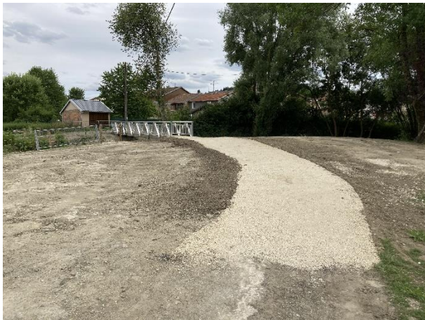
Après pose de la passerelle et remise en place des réseaux de télécommunication sous la passerelle, le cheminement, avant travaux en enrobé et dégradé par le passage des différents engins, a été remis en état mais en créant un cheminement uniquement piéton et perméable en concassé calcaire.
