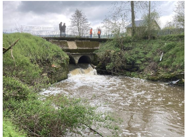
Vue depuis l'aval sur l'ouvrage à dégrader. Dénivelé cumulé amont 2,50 m.
