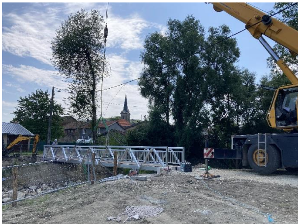
Pose de la passerelle en aluminium et platelage bois.
