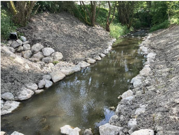
Le lit du ruisseau de Beauchamp a également été réaménagé à l'aval de l'ouvrage : comblement partiel de la fosse, réaménagement des berges en pente douce et réaménagement de la sortie d'eaux usées de la commune. Ensemencement et bouturage des berges ont complétés l'aménagement aval du lit mineur. Photo prise depuis l'amont au droit de l'ancien ouvrage.
