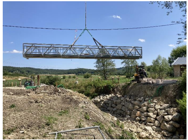
Pose de la passerelle de 14 m sur des massifs bétons prévus à cet effet ; eux-mêmes fixés sur micro-pieux de 6m.
