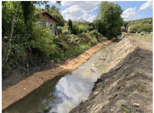
La banquette de rive argilo-terreuse façonnée a ensuite été protégée par un géotextile biodégradable et ensemencée.
