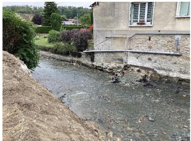
Lit de la Biesme après dérèglement du seuil amont et du muret maçonné de rive gauche.
