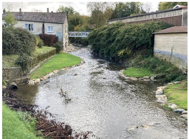
Vue sur les banquettes végétalisées et le lit de la Biesme sinueux et diversifié entre la passerelle et le pont de la RD 63 : radier, mouille et plat courant se succèdent sur ces 80 ml. En arrière-plan la passerelle piétonne au droit du seuil dérasé de l'ancien moulin.
