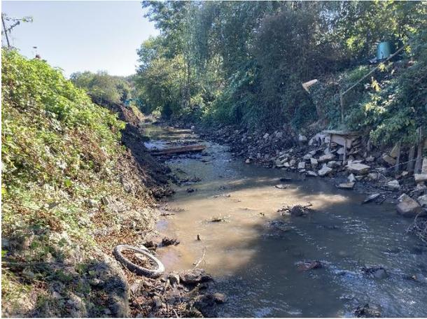
De nombreux déchets divers inertes se retrouvent dans l'ancien remous : roues, blocs de béton, taules, ... surtout au pied de toute la rive gauche où blocs béton, palplanches, taules, servent de renfort de pied de berge contre l'érosion de la Biesme.
