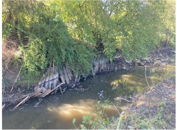
Protection de berge en rive gauche déstabilisée faite de palplanches. Toutes les palplanches ont été enlevées avant de réaménager le pied de la rive gauche.
