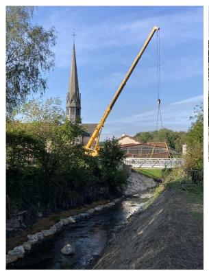
Mise en œuvre d'une nouvelle passerelle piétonne adaptée à l'élargissement avec le retalutage en pente douce de la berge gauche. Nouvelle passerelle longue de 14 m.
