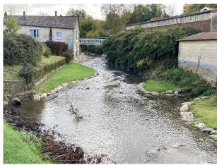
Vue sur les banquettes végétalisées et le lit de la Biesme sinueux et diversifié entre la passerelle et le pont de la RD 63 : radier, mouille et plat courant se succèdent sur ces 80 ml. En arrière-plan la passerelle piétonne au droit du seuil dérasé de l'ancien moulin.
