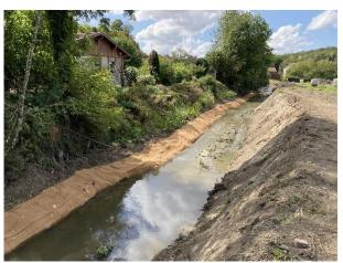
La banquette de rive argilo-terreuse façonnée a ensuite été protégée par un géotextile biodégradable et ensemencée.
