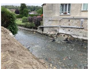
Lit de la Biesme après dérasement du seuil amont et du muret maçonné de rive gauche.
