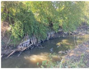
Protection de berge en rive gauche déstabilisée faite de palplanches. Toutes les palplanches ont été enlevées avant de réaménager le pied de la rive gauche.
