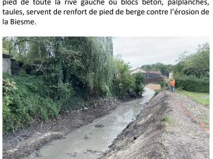
Sur les 200 m amont à l'ancien seuil, les travaux ont consisté à retaluter légèrement la berge de rive droite afin de prélever des matériaux terreux pour façonner une banquette continue en pied de rive gauche pour stabiliser cette berge bordant jardins et installations diverses (abris, clôtures grillagées, murets, ...). Le plus gros des matériaux inertes de type béton et ferrailles ont été préalablement retirés du lit avant façonnement des banquettes.
