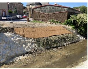
Protection de berge de rive gauche aménagée avant mise en place de la nouvelle passerelle.
