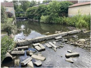
Vue sur les deux seuils faisant obstacle à la continuité écologique dans la traversée de Vienne-le-Château. Hauteur du seuil aval = 45 cm. Hauteur du seuil amont = 140 cm (chute d'eau 1,20 cm en étiage).
