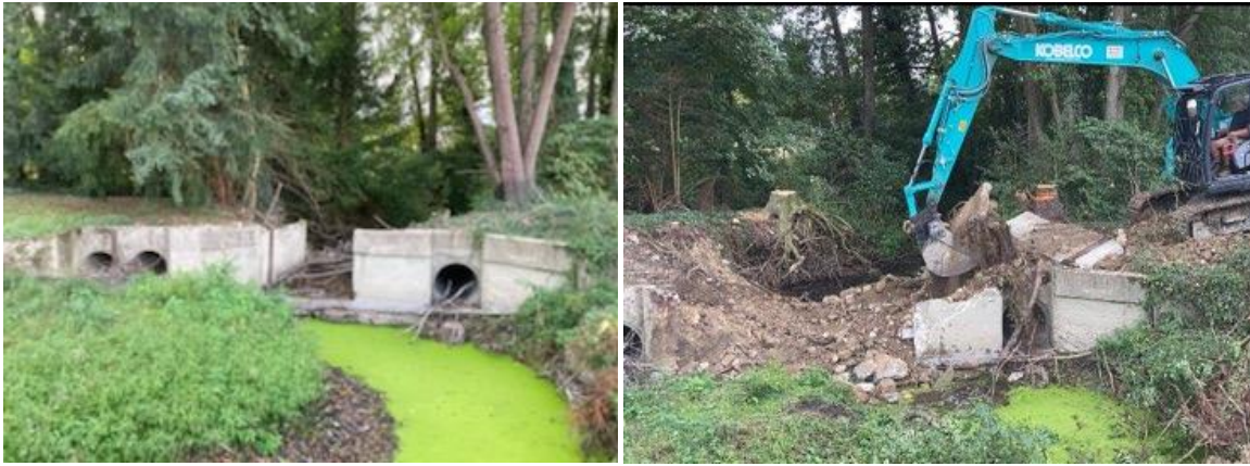
Figure 3 : Maçonneries aval - Avant et en cours de démolition
