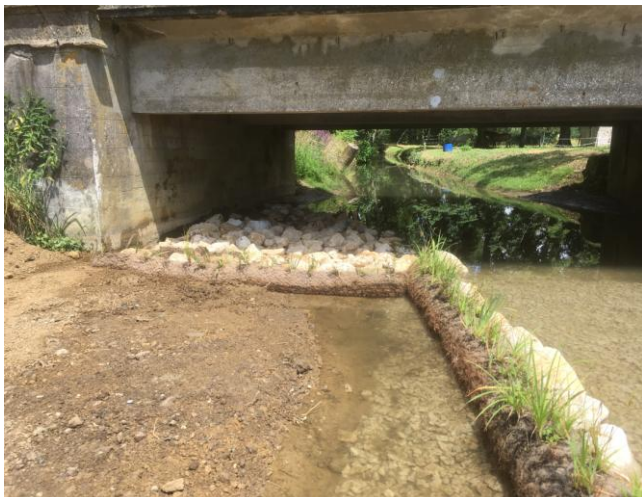
Resserrement du lit d'étiage sous le pont de la RD
