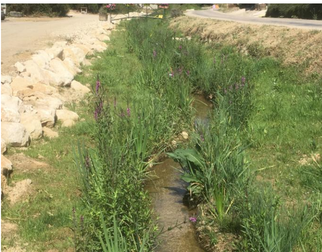
La traversée de Sommaisne 1 mois après travaux
