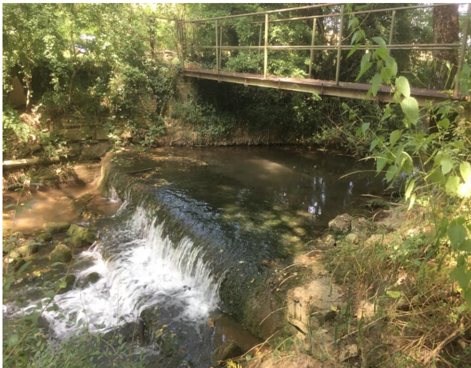
Seuil de l'ancien moulin de Senard (hauteur de chute de 80 cm)
