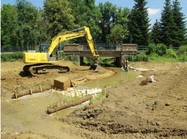
Mise en place d'un géotextile biodégradable sur la banquette de rive droite située l'axe du pont afin se prémunir de problèmes de ravinement en cas de gros épisode pluvieux et avant végétalisation des banquettes
