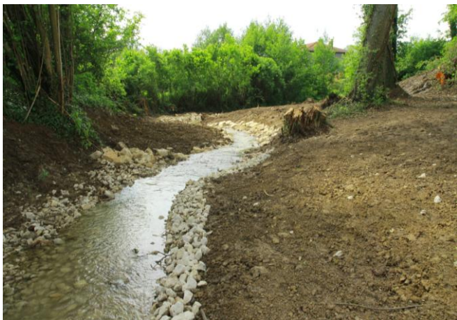
Mise en place d'un substrat diversifié (concassé calcaire 0-150), afin d'une part apporter de la rugosité au lit pour freiner les vitesses d'écoulements et diversifier les faciès ; et d'autre part créer un substrat propice à l'accueil des peuplements piscicoles de première catégorie piscicole.
