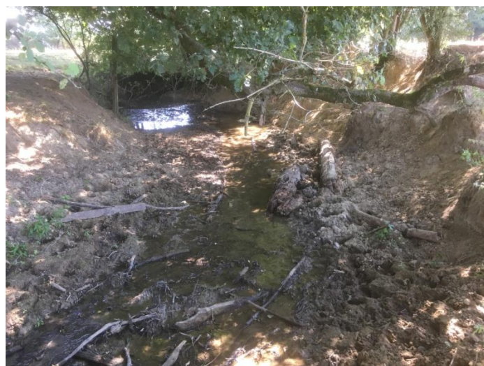
Le Sainsonrupt (affluent de la Marque) sur Triaucourt. Piétinement très impactant sur ce cours d'eau aux étiages très marqués (piétinement continu du lit et des berges sur plus de 400 ml de rivière)
