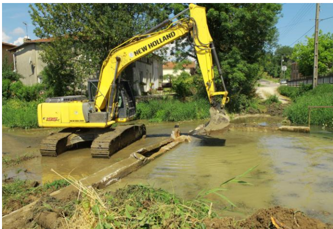
Après travaux de désenvasement, dérasement du seuil
