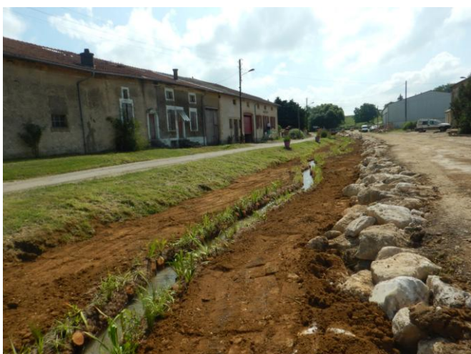
Lit d'étiage après travaux (vue depuis l'aval)
