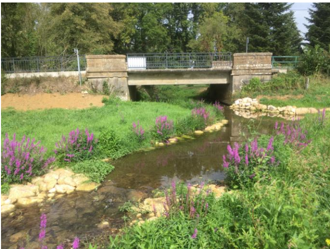
Lit mineur de l'Aisne, 1 mois après travaux
