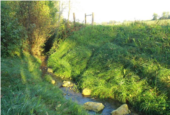
Connexion amont entre le lit du Thabas et la rivière de contournement (nouveau lit)
