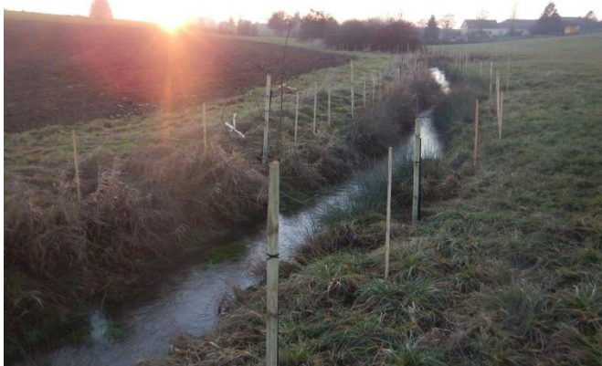
Plantation d'une ripisylve d'arbres et arbustes sur 200 ml de rivière depuis la source de l'Aisne (ripisylve absente avant travaux)
