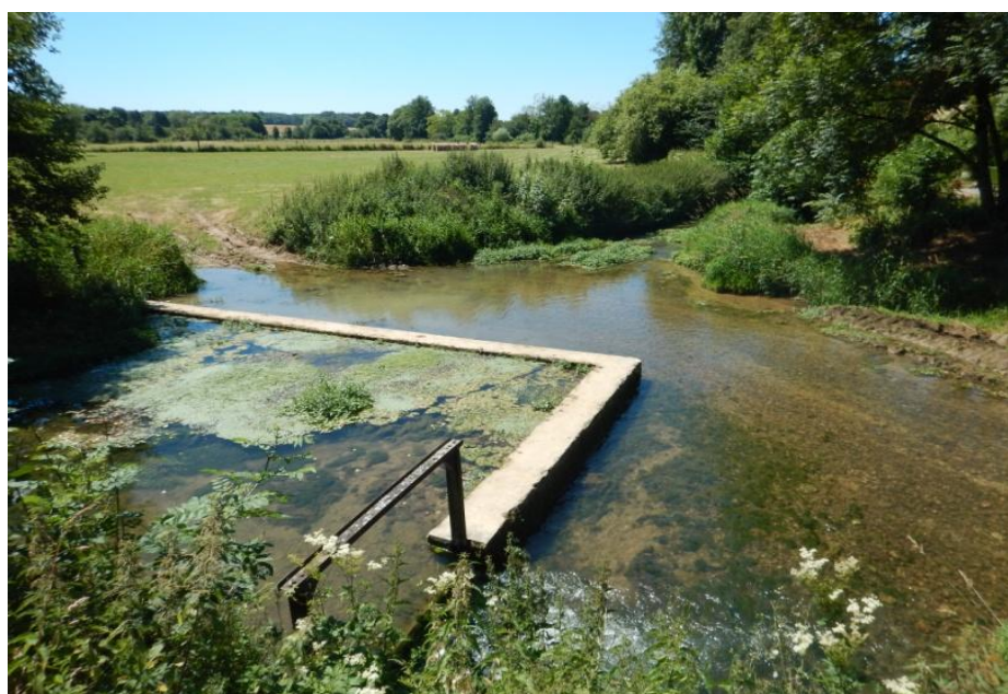
Vue depuis le pont de la RD2 sur le passage à gué et le seuil en équerre infranchissable
