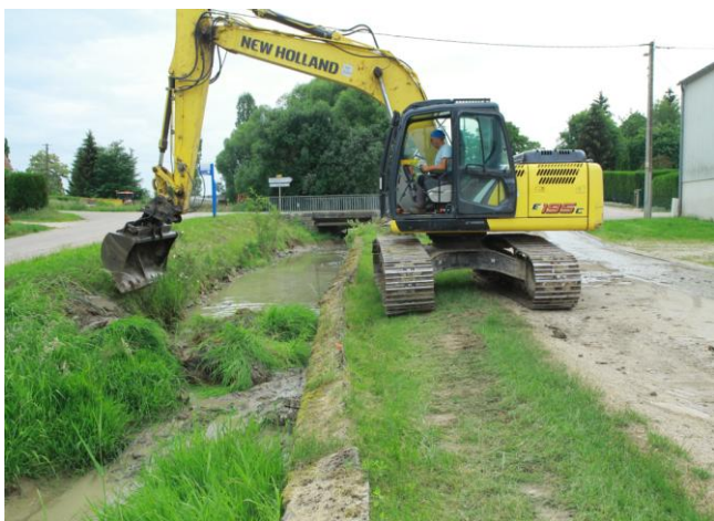
Désenvasement du lit de l'Aisne dans toute la traversée du village
