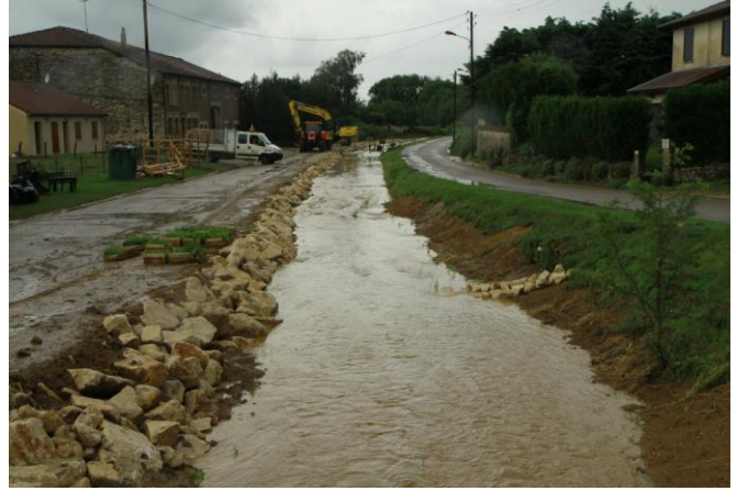
Suite à un fort épisode orageux lors des travaux, l'aménagement a été mis à l'épreuve
