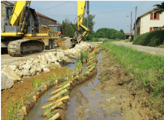
Lit d'étiage créé par aménagement de banquettes végétalisées, maintenues par des boudins pré-plantés d'hélophytes, eux-mêmes maintenus par une rangée de pieux imputrescibles
