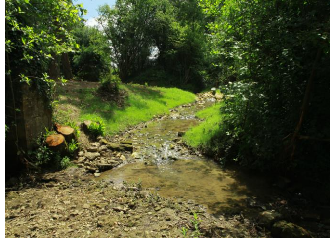
Confluence ancien bras de décharge – aval seuil, après aménagement de la rivière de contournement
