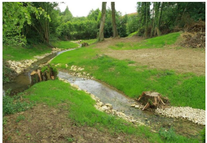
Rivière de contournement, 3 semaines après travaux (en période d'étiage marqué)
