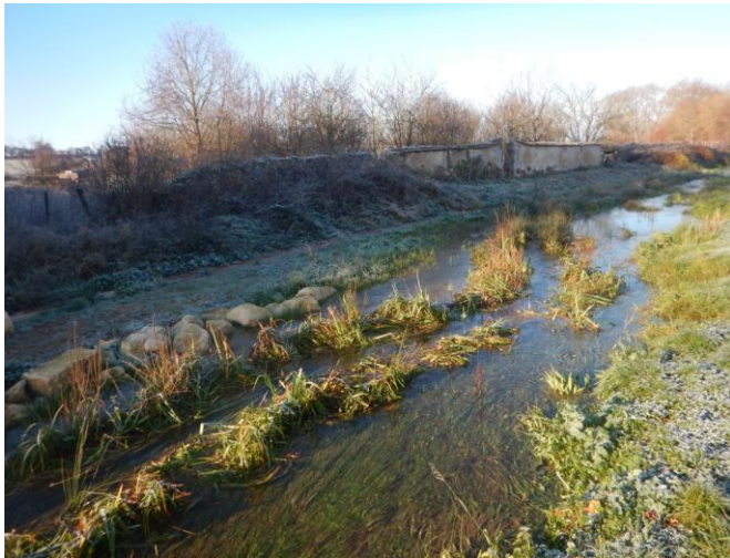
La traversée de village en période de hautes eaux (décembre 2018) : banquettes inondées
