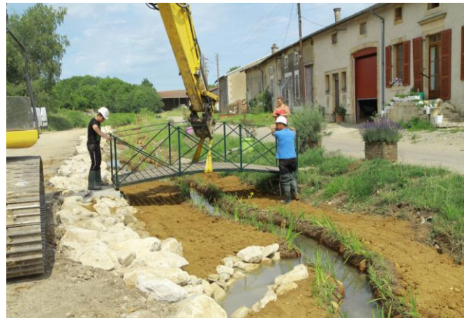
Repose de la passerelle et aménagement des sorties du pluvial
