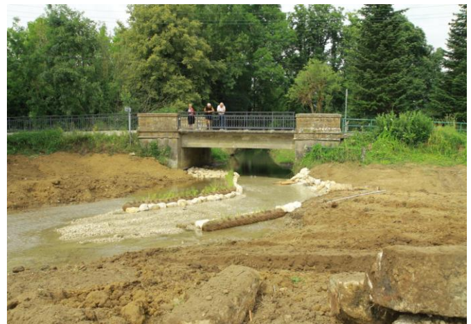
Suppression du passage à gué et création d'un lit mineur dans l'axe du point : aménagement de banquettes végétalisées, maintenus en bordure par des boudins d'hélophytes. Apport d'un substrat au sein du lit mineur.
