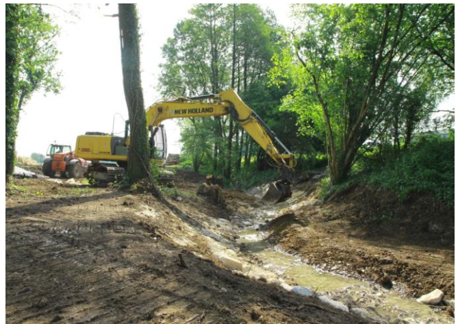
Diversification du lit mineur (retalutage des berges en pentes douces, création de risbermes, créations de sinuosités,...)
