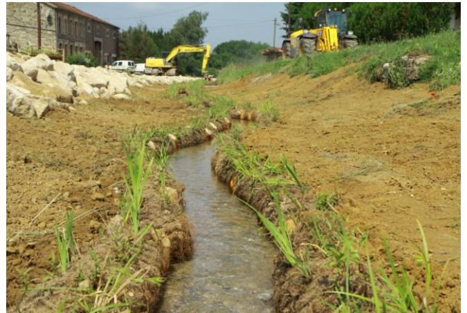
Lit d'étiage après travaux : lit d'étiage de 80 cm de largeur, proche du gabarit naturel de l'Aisne au niveau des sources de l'Aisne (source située 300 m en amont du village). Apport d'un substrat de graviers roulés dans le lit d'étiage
