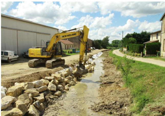
Remplacement du muret maçonné par des enrochements non gélifs
