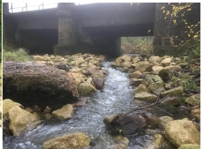
Vue sur le lit d'étiage créé et les contre-seuils aval : Continuité écologique rétablie en toute condition hydrologique. En période de crue, les écoulements peuvent se faire sous les deux arches.
