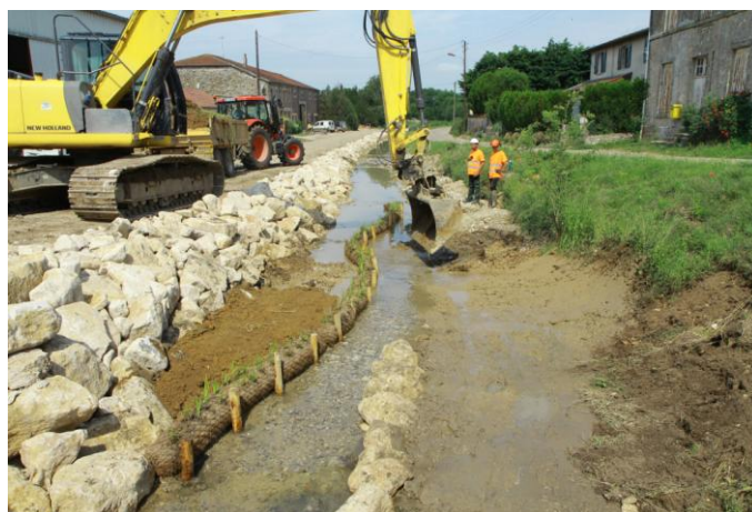
Création d'un lit d'étiage
