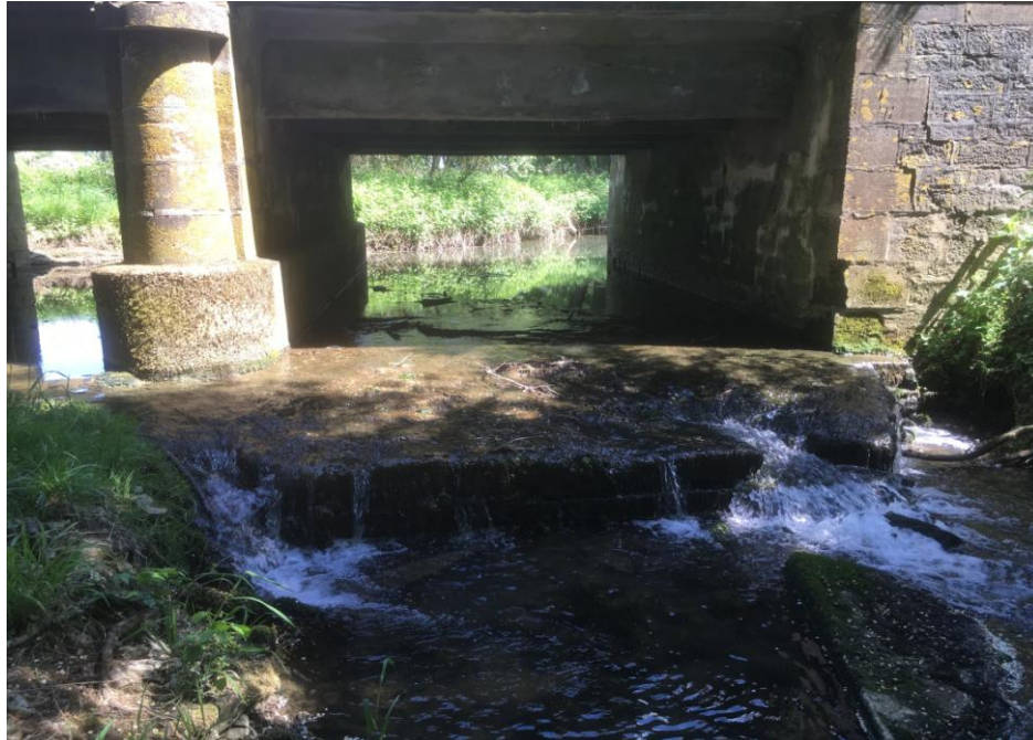
Radier du pont infranchissable en période d'étiage/module : chute d'eau de 40 cm et étalement de la lame d'eau sur les deux arches du pont
