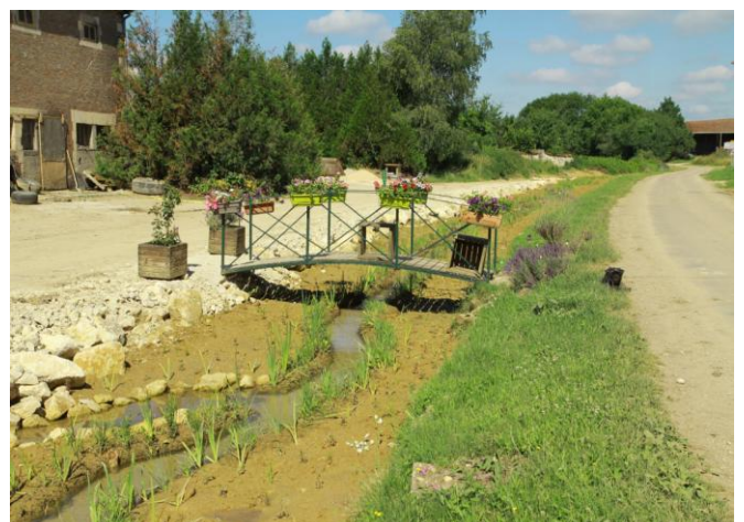
Lit d'étiage après travaux (vue au droit de la passerelle, milieu du village)
