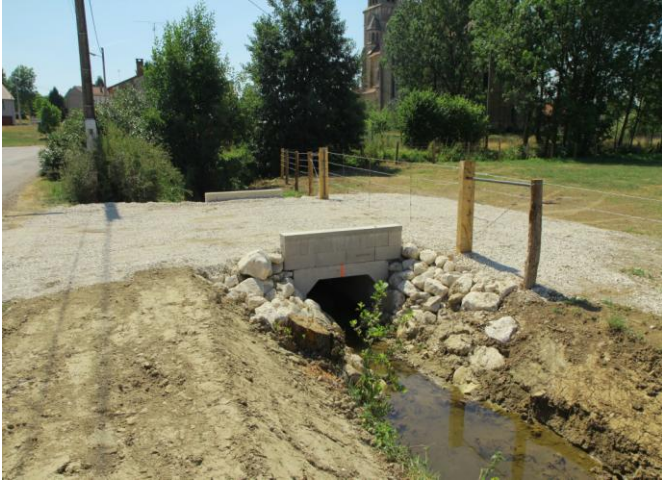
Pont-cadre après travaux
