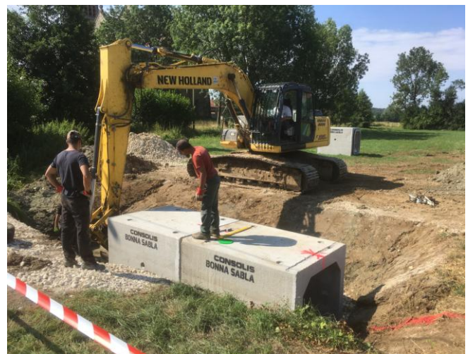
Aménagement d'un accès agricole aux parcelles de rive gauche suite à la suppression du passage à gué (seul accès possible avant travaux). Aménagement d'un pont-cadre sur le bras de l'Aisne le long de la RD 2
