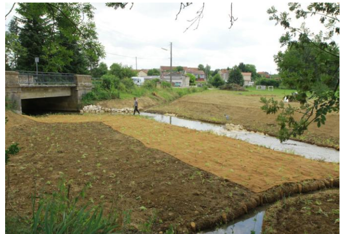
Vue sur le lit mineur de l'Aisne réaménagé depuis la rive droite
