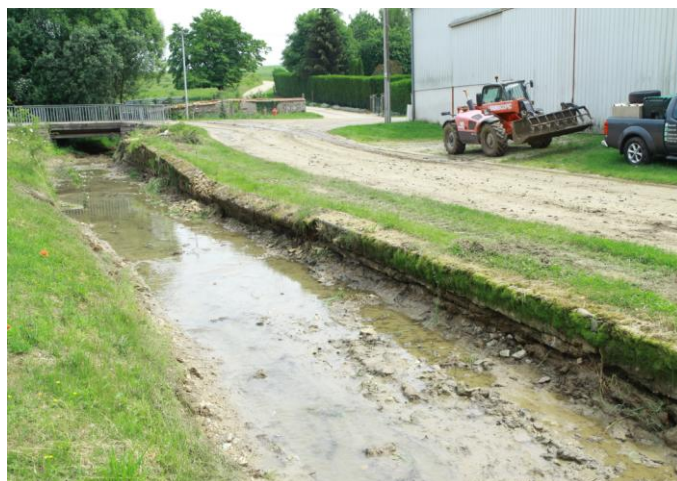
Dérasement de l'ensemble du muret maçonné de rive gauche déstabilisé et glissant dans le cours d'eau
