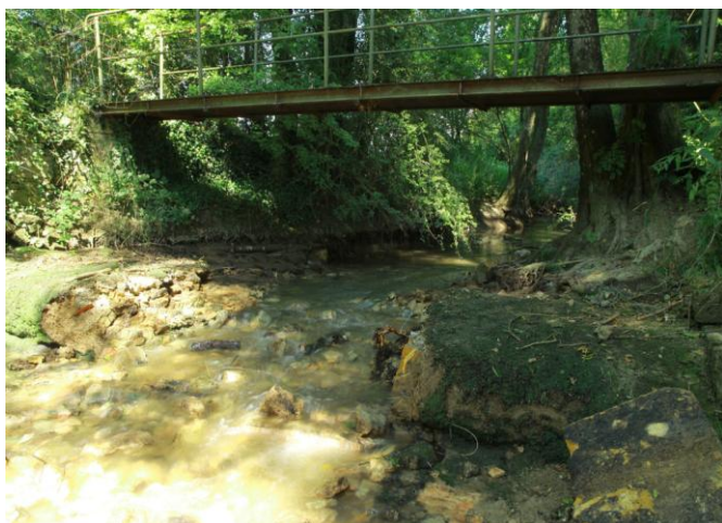
Travaux de dérasement du seuil : conservation de l'ancrage en berge, large échancrure de 3-4 m pour conserver un bon tirant d'eau en étiage et des dimensions du lit mineur de l'Aisne plus conforme à son gabarit original.
