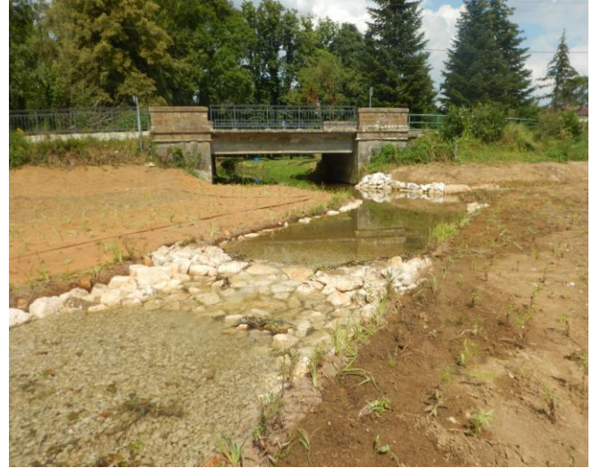
Création d'un micro-seuil sous forme de rampe en enrochements (chute < 10 cm en étiage), calé sur la cote de l'entrée du bras de l'Aisne, pour assurer une bonne alimentation du bras quelque soit le débit de l'Aisne
