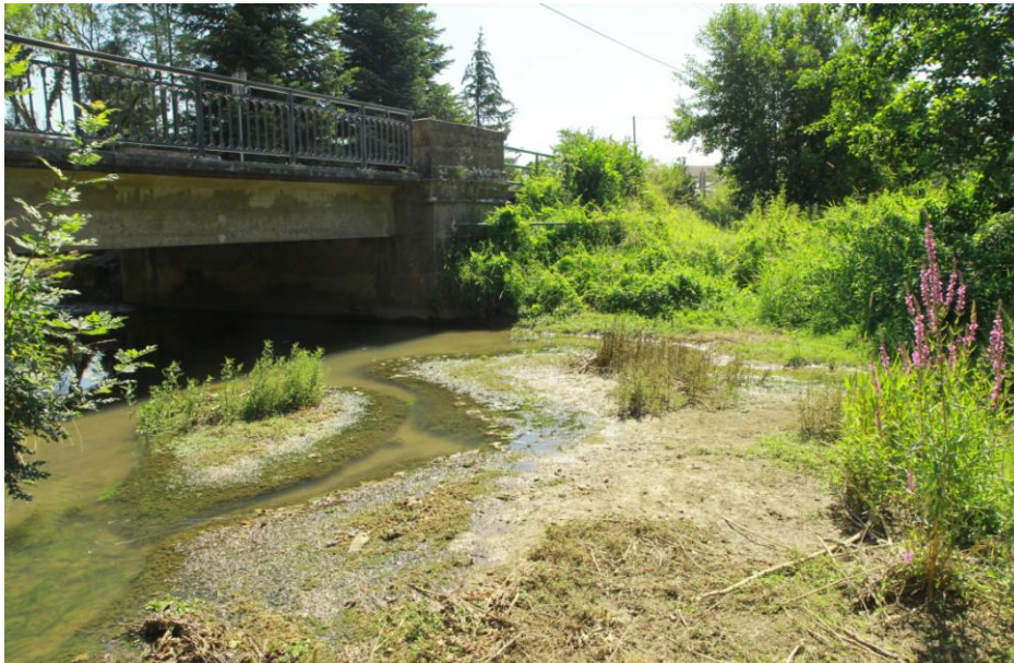
Seuil complètement envasé, ainsi que l'entrée du bras de l'Aisne en rive gauche (déconnecté en période d'étiage. Gestion par curage « non autorisé » avant réalisation du projet du SMAVAS.
