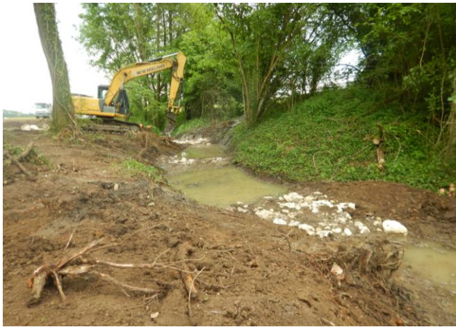
Après désenvasement et reprofilage du futur lit, mise en place d'une succession de seuils en enrochements ancrés en profondeurs, pour écrêter et rattraper la hauteur de chute de l'ouvrage (différence de cote entre chaque seuil < 15 cm)
