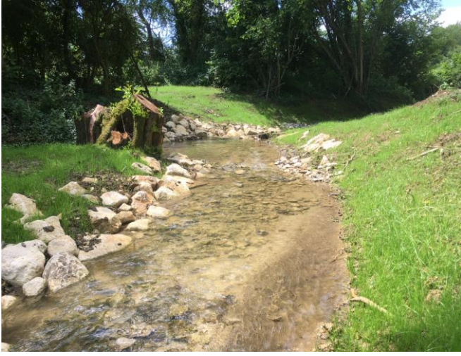
Lit mineur 3 semaines après travaux (berges végétalisées, reprise des boutures de saules et des cépées d'aulne, transit sédimentaire rétabli avec dépôt sables, graviers et limons)
