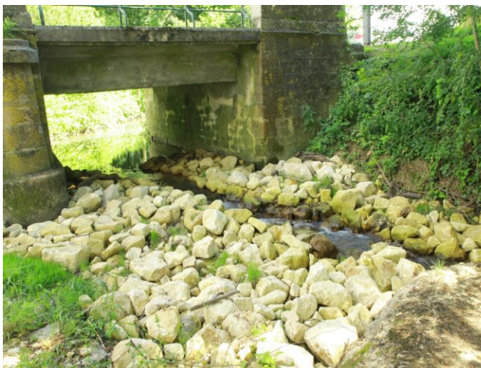
Aménagement d'un lit d'étiage concentré sur une seule arche et aménagement d'une succession de micro-seuil en aval du radier pour écrêter la hauteur de chute
