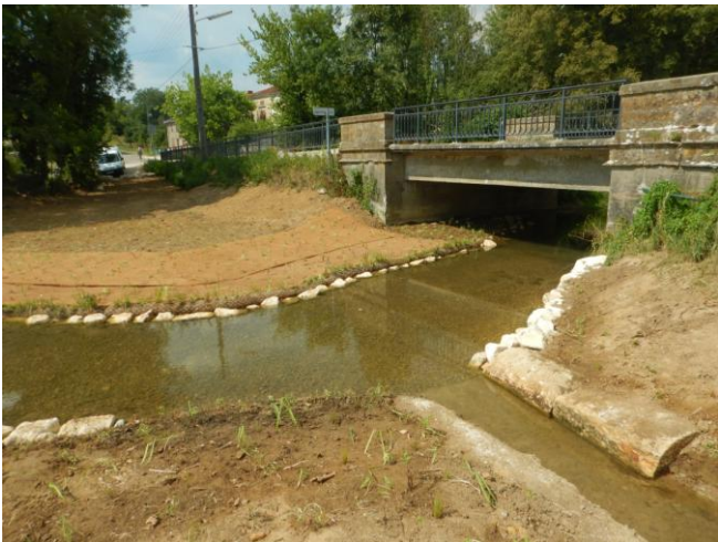
Entrée du bras de l'Aisne désensasé et réaménagé (entrée du bras calibrée avec réutilisation de pierres de taille issus du seuil démantelé)
