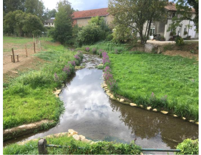
Lit mineur de l'Aisne, 1 mois après travaux (vue depuis le pont de la RD)
