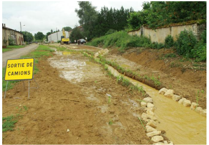
L'ancien passage à gué réaménagé, après l'épisode orageux
