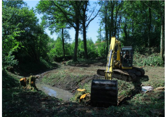
Reprise de l'ensemble du profil en long, avec déblais des tronçons comblés
