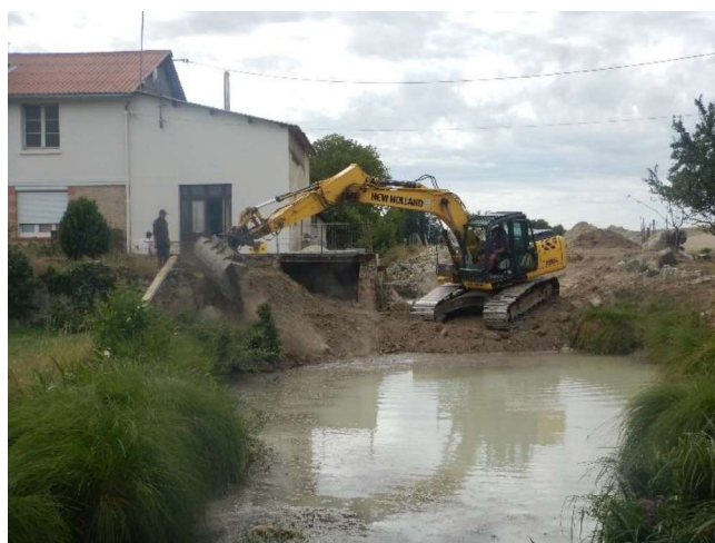
Façonnement de la berge droite en aval de l'ancienne prise d'eau du moulin. Seule partie de l'ancienne fosse de dissipation remblayée.
