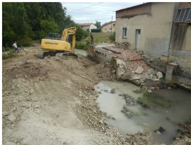
Les matériaux terreux déblayés au droit du muret dérasés sont disposés sur le radier, afin de permettre à la pelle un accès pour façonner la berge aval à l'ancienne prise d'eau au-dessus de la fosse de dissipation.
