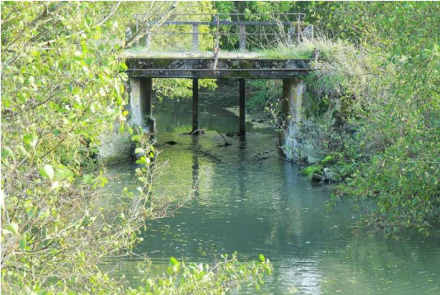
Aval du radier du pont ennoyé
