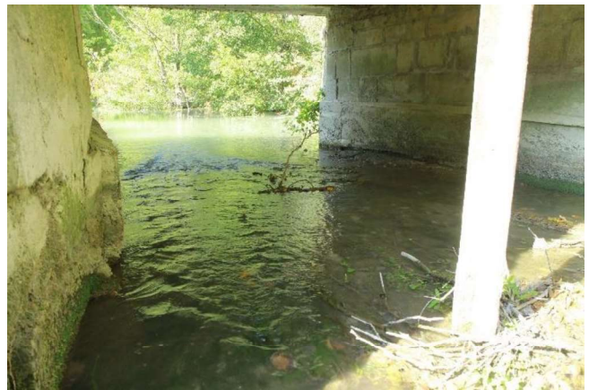
Vue amont de l'ouvrage après travaux.
