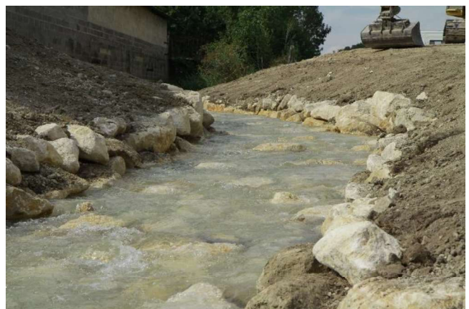
Vue sur le lit mineur et l'effet de dissipation des blocs épars ancrés.
