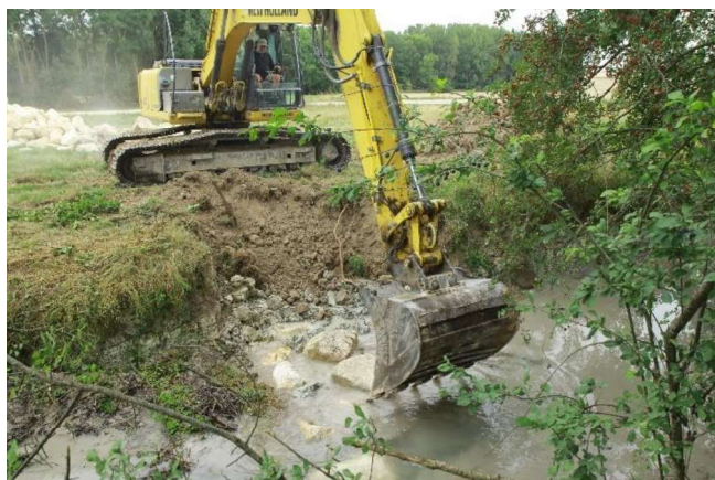
Ancrage des seuils en berges.
