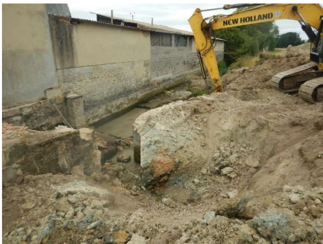
Dérasement du muret maçonné de rive gauche au droit de l'ancien vannage. La dérivation réalisée en rive gauche permet de travailler en assec.
