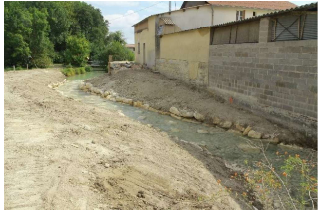
Vue d'ensemble sur le nouveau lit depuis l'amont.
