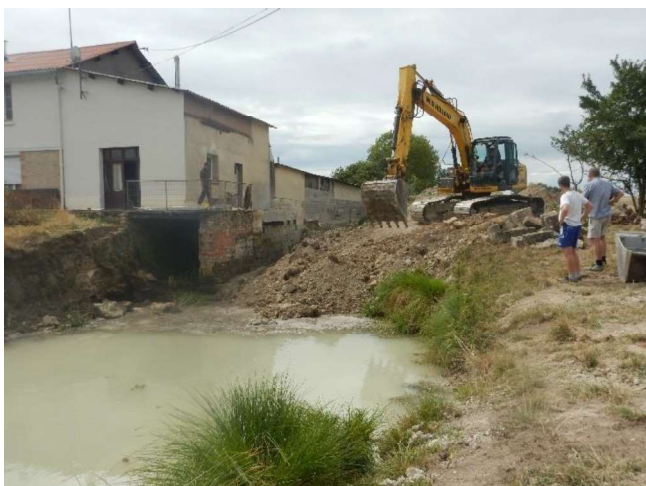
Le muret de rive droite déstabilisé en aval de l'ancienne prise d'eau est arasé. Une assise de blocs au pied de la rive droite et dans la fosse de dissipation est façonnée avant mise en œuvre de la berge en matériaux terreux.
