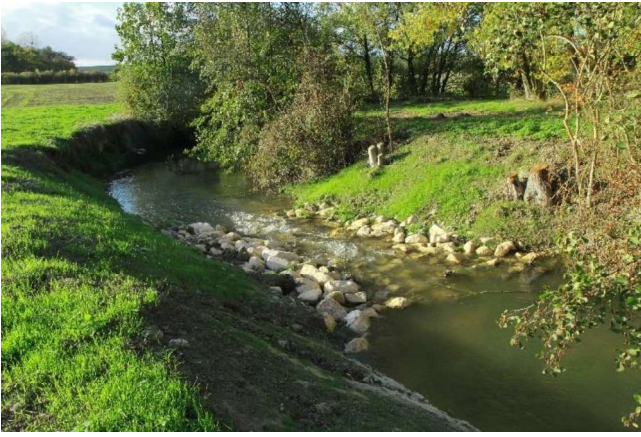
Seuil aval vu depuis l'amont
