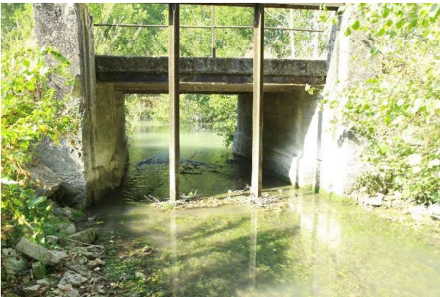
Vue amont de l'ouvrage après travaux.
