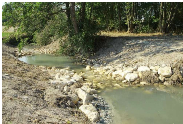
Vue sur les deux seuils depuis l'amont après travaux
