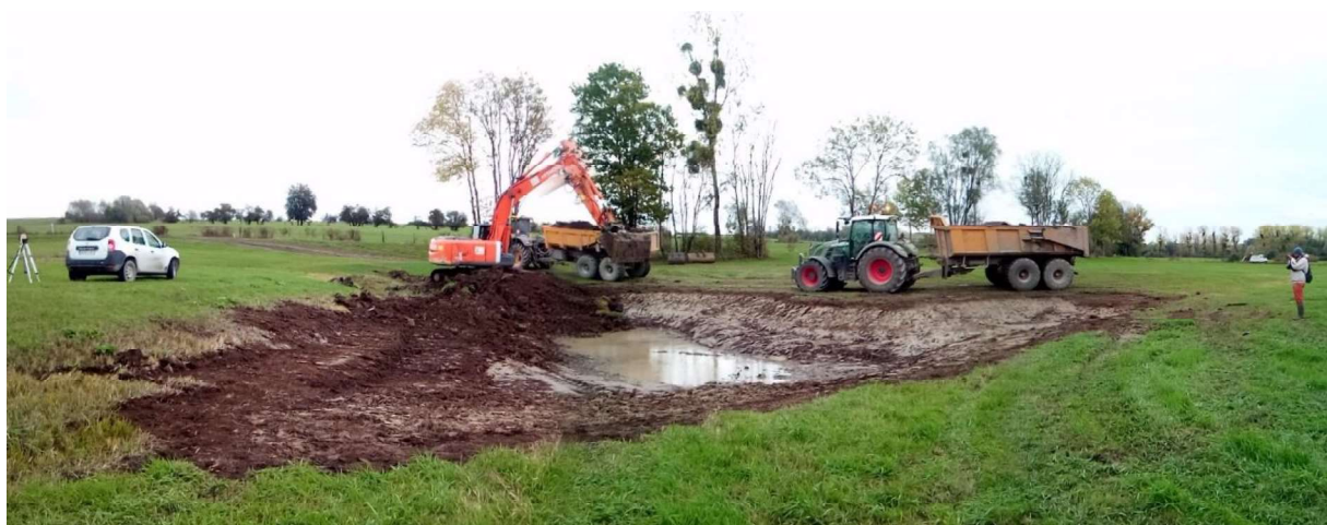
Restauration de la mare en queue d'annexe – Approfondissement et diversification des berges (berges sinueuses, avec une pente plus ou moins prononcée, risbermes, ... etc.)
