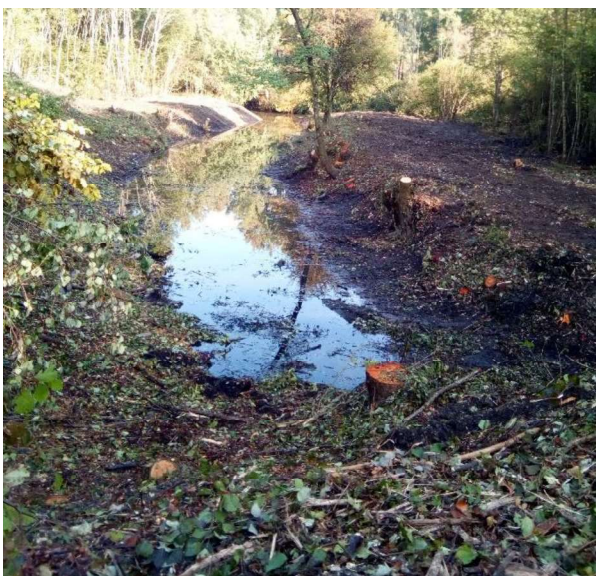
Vue depuis le fond de l'annexe après travaux
