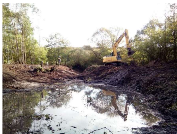
Désenvasement et retalutage des berges du chenal de connexion
