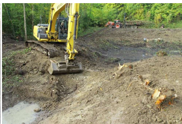
Désenvasement et retalutage des berges du chenal de connexion
