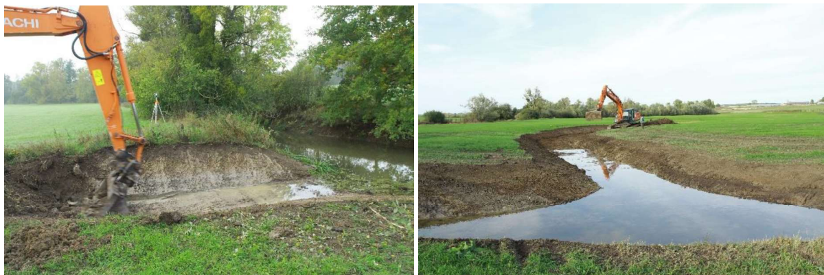
Reprise de la partie aval du fossé de drainage de l'étang afin de faciliter la connexion avec l'Aisne et création du chenal de connexion entre l'ancien tracé de l'Aisne et le fossé
