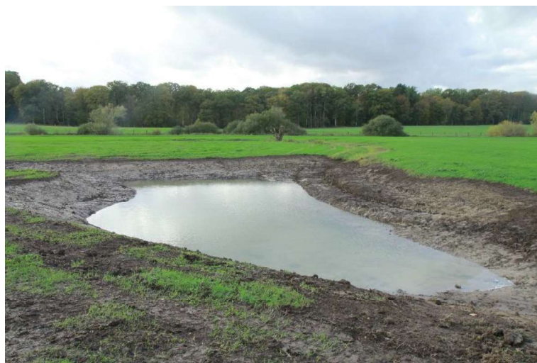
Mare restaurée partiellement en eau 2 semaines après travaux.
