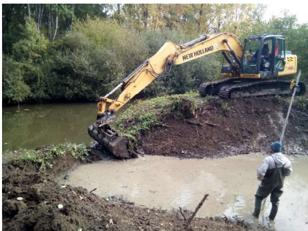
Retrait de matériaux au niveau de la connexion et talutage des berges au niveau de la connexion
