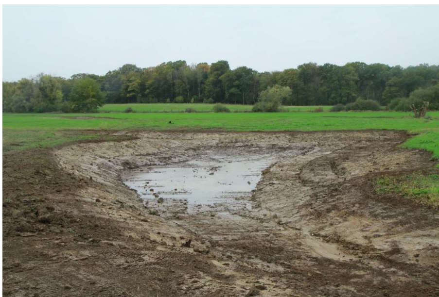
Mare de 250 m 2 diversifiée (aménagement de risbermes sur une rive, variation des pentes et des profondeurs, sinuosité des berges, aménagement d'une mardelle de faible profondeur connectée à la grande mare, ...)
