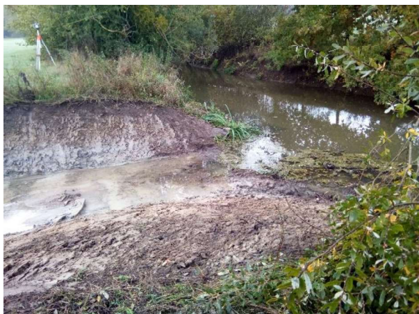
Retrait de matériaux au niveau de la connexion et talutage des berges au niveau de la connexion
