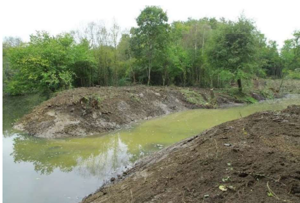
Connexion après travaux
