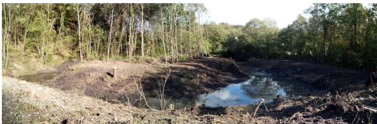
Annexe hydraulique après travaux – A droite la connexion avec l'Aisne
