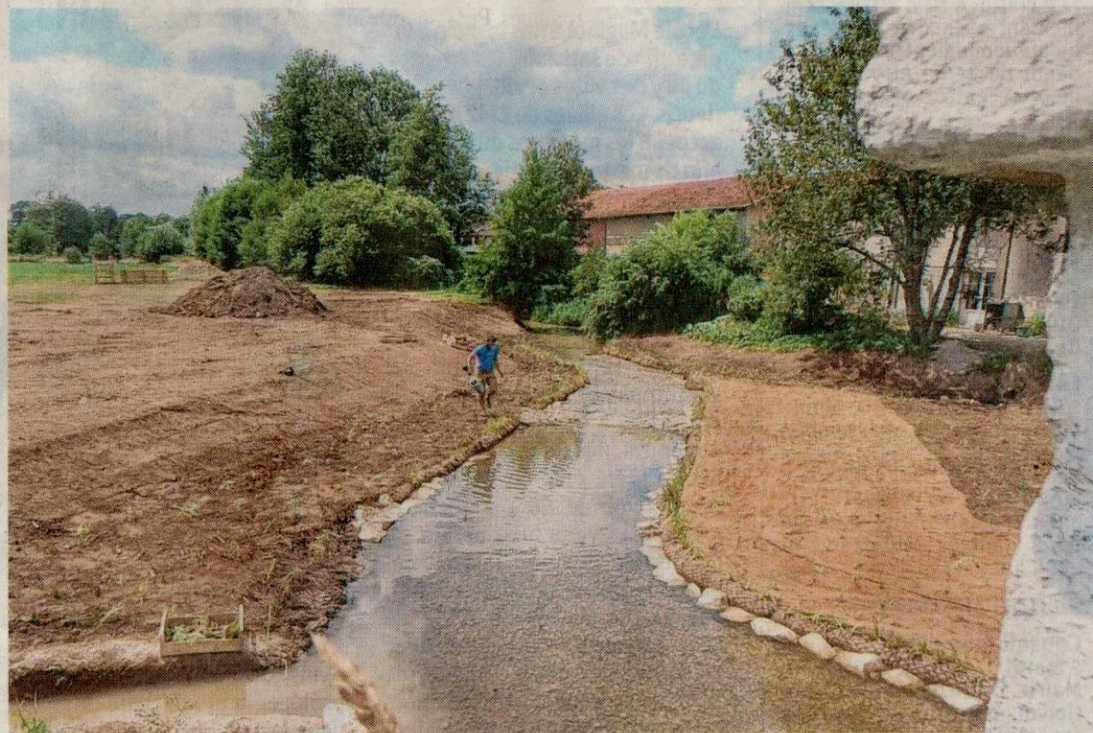
Le nouveau cours de l'Aisne après la réalisation des travaux de restauration hydromorphologique.
