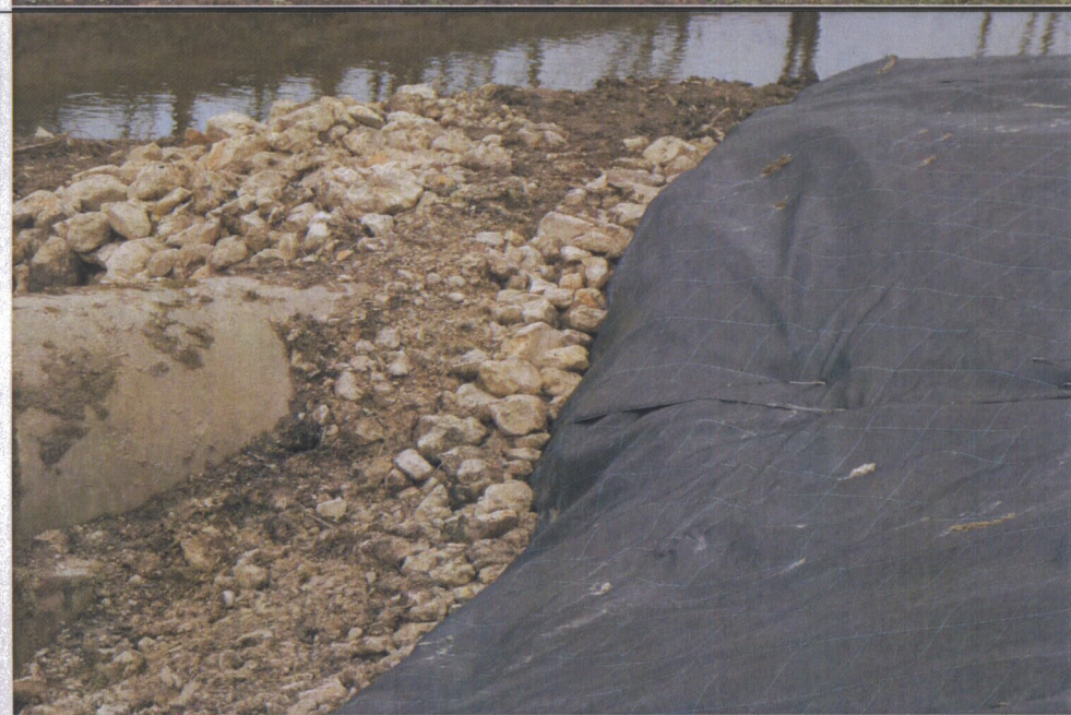
Positionnement des bâches sous l'empierrement et jusqu'à l'ouvrage busé.
